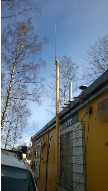
Kuva 20. Työmaalle asennettu oma tukiasema-antenni
