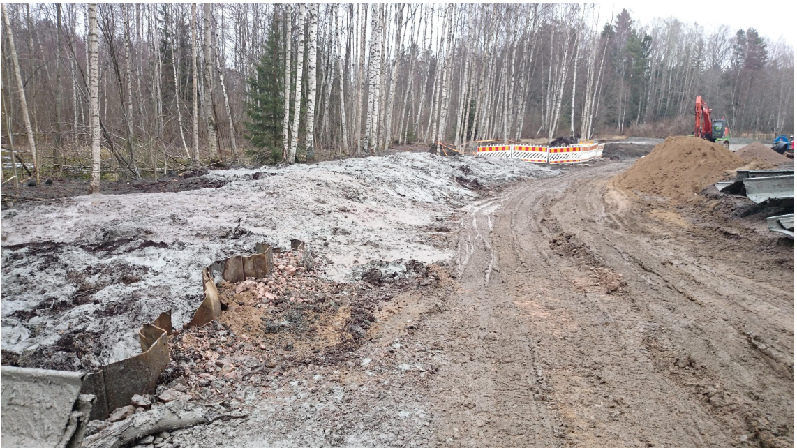
Kuva 18. Savimaa toi haasteita maamassojen käsittelyssä
