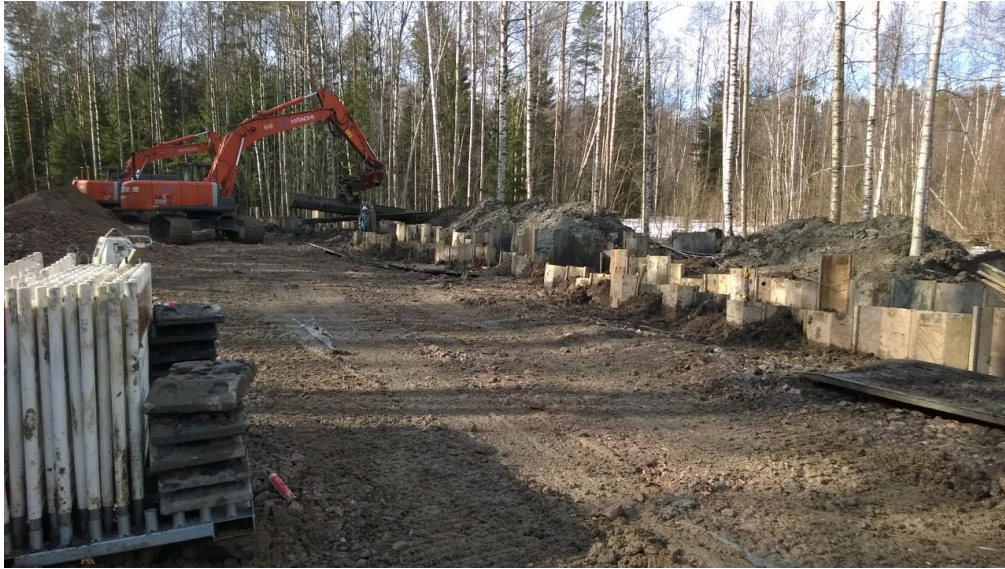
Kuva 16. Putkilinjaa ympäröivät puut loivat haasteet radiosignaalin kuuluvuudelle
