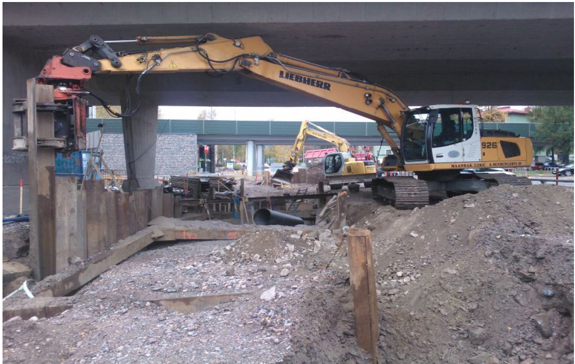
Kuva 14. Yhdellä kehikolla tuettu kaivanto. 4-osainen kehikko
