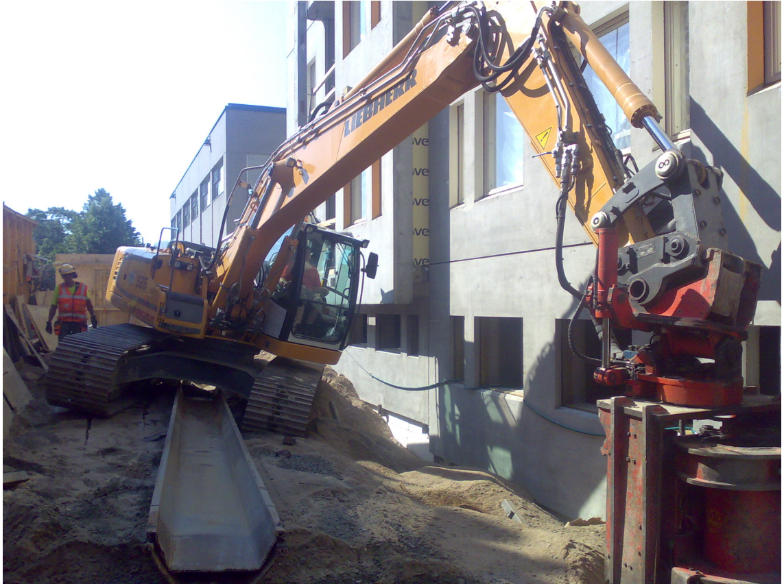
Kuva 32 Valmiin talorakenteen lähellä tapahtuva pontin nosto. Etäisyys työkoneesta seinään noin 40 cm
