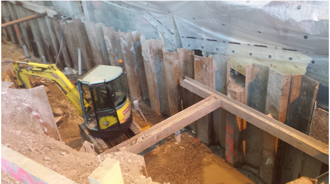
Kuva 3. Valmiin rakenteen alusrakennetta tukeva ponttiseinä. Kevytpeittein suojatun seinän takana Postitalo.
