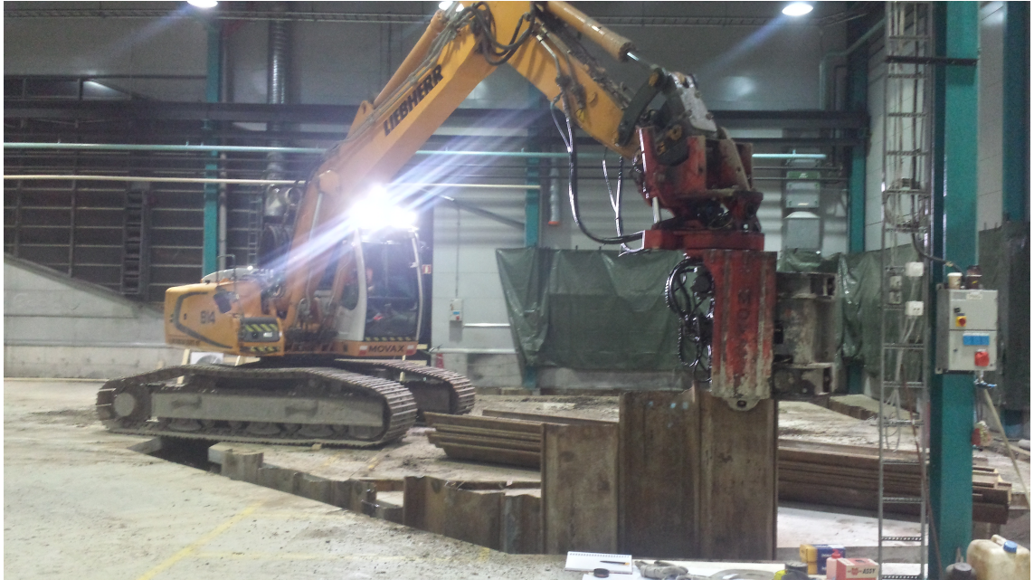
Kuva 33. Auki leikattuun teräsbetonirakenteeseen lyötävää ponttiseinää kuusimetrisistä ponteista
