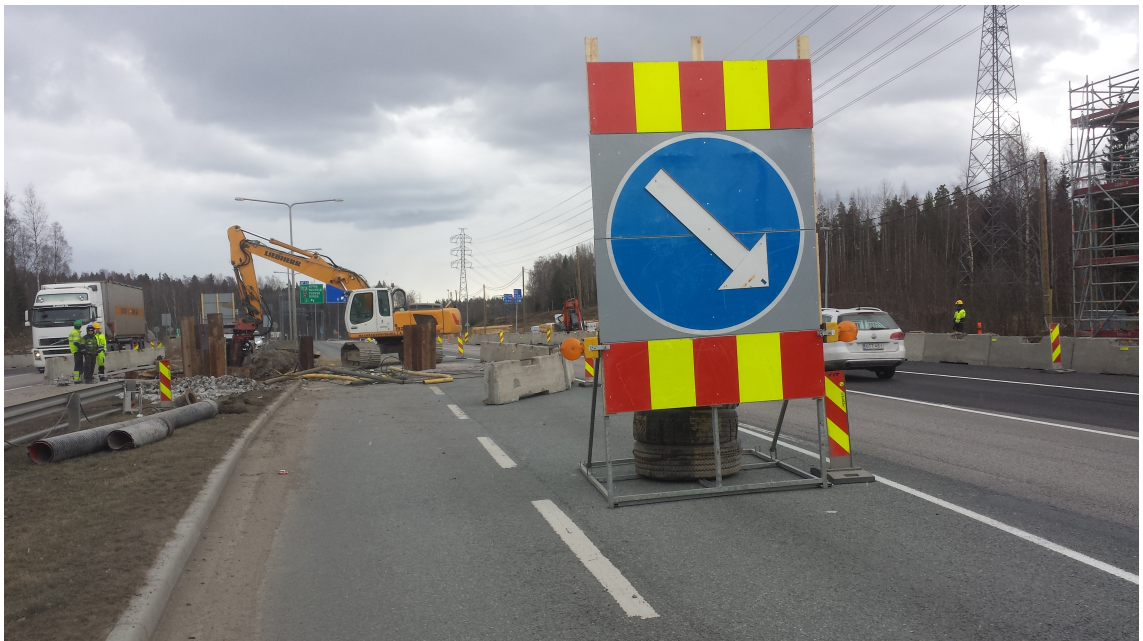
kuva 28. Katualueella tehtävä siltapilarin pontitustyömaa
