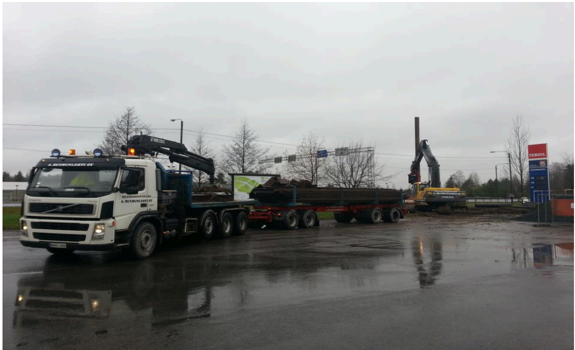
Kuva 30. Kehikoiden ja ponttien purku täysiperäyhdistelmästä.
