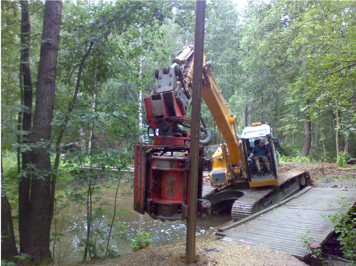
Kuva 8. Luontopolun siltalaatan alustan putkipaaluus
