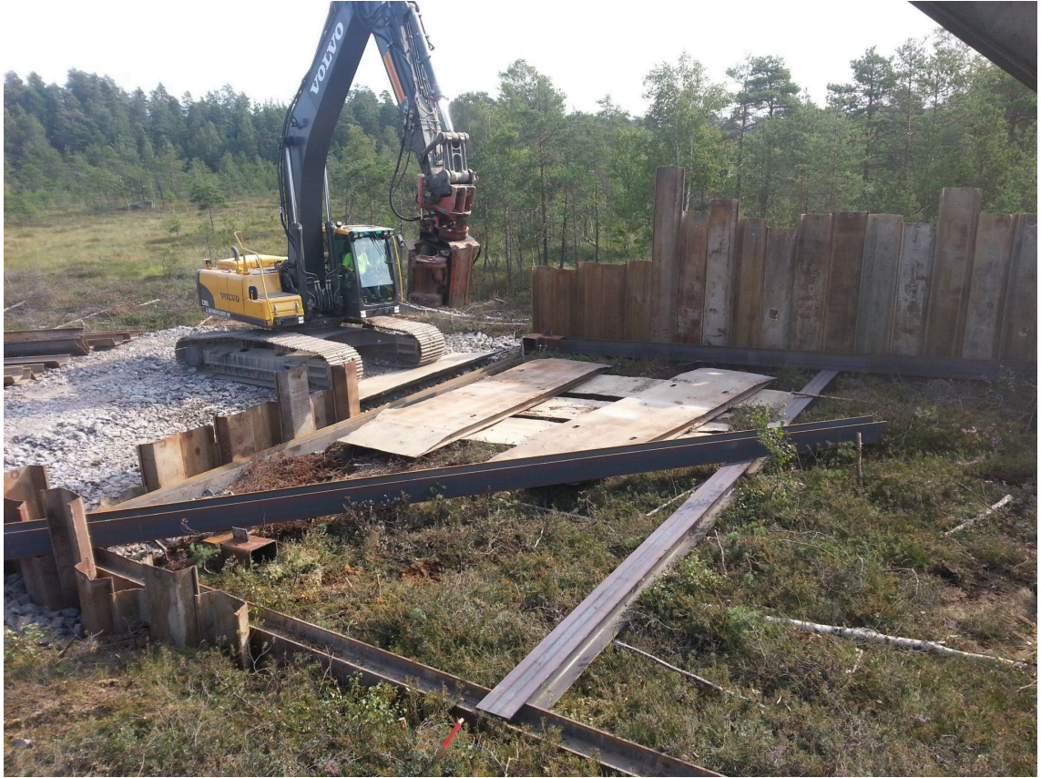
Kuva 5. Vesitiiviin ponttirakenteen teko suolle suurvoimalinjatolpan anturaa varten Kilpilahdessa
