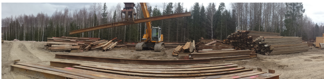
Kuva 24. Lastauksen valmistelu rautavarastolla.
