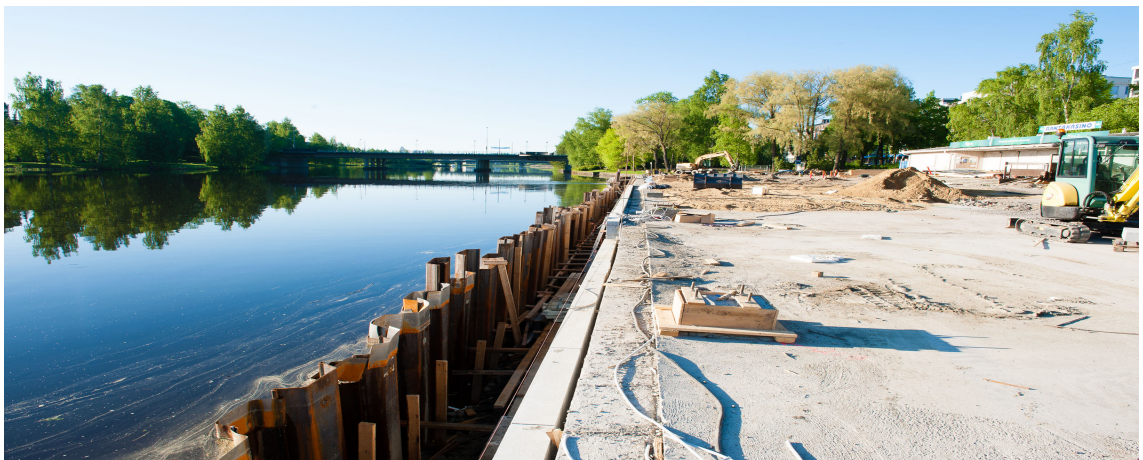
Kuva 6 Hämeenlinnan rantakasinon laiturin levitys työmaalla riittävä vesitiiviys saavutettu. Tiivistysaineena käytetty turpoavaa sahanpurua
