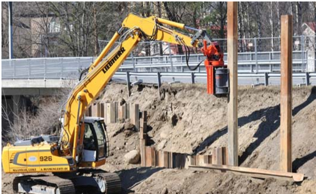
Kuva 13 Yhtenäisen ponttiseinän teko, Tiepenkan tuenta
