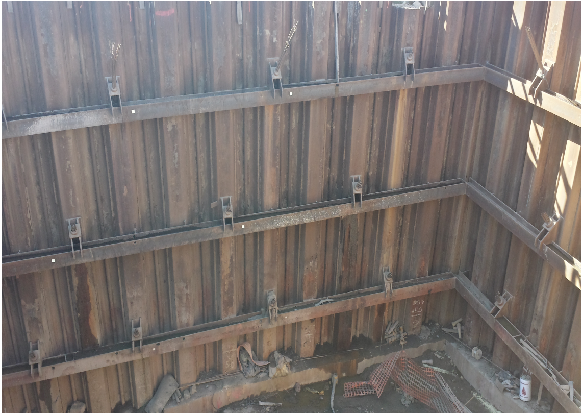
kuva 21. Kolmelta tasolta kallioankkuroitu ponttiseinä Matinkylän metrotunneliin
