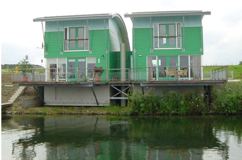
KUVA 5. Maasbommelin rakennukset seisovat kuivalla maalla kun ei tulvi. Rakennusten välissä näkyy paalu, joka estää rakennusten sivuttaisliikkeen (Inspiration Green 2014)
