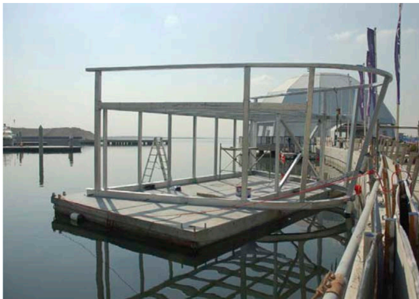
KUVA 8. Kelluvissa rakennuksissa käytetään kevyitä runkoratkaisuja (Marina housing 2009)
