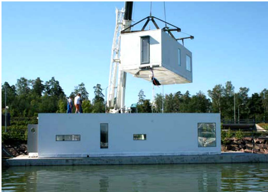
KUVA 10. Kelluva rakennus voidaan kasata talomoduuleina (Marina housing 2009)
