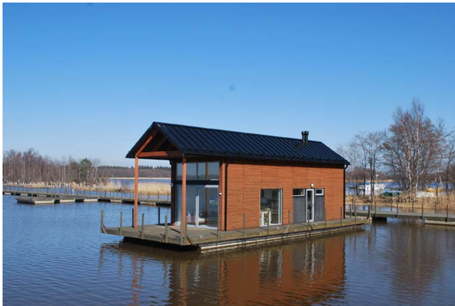
KUVA 3. Porin Reposaareen rakennettu kelluva asunto (Seppä 2013)
