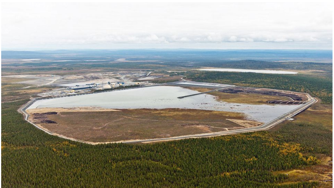
Kuva 4. Kevitsan rikastushiekka-allas A. Tehdasalue näkyy altaan takana vasemmalla (Ylen www-sivut 2013, hakupäivä 20.11.2013)
