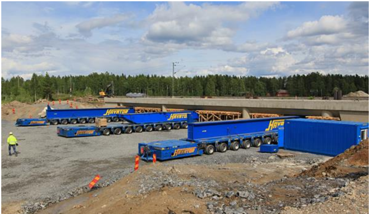
Kuvio 2. Sillan siirto SPMT-menetelmällä. (Havator 2014).
