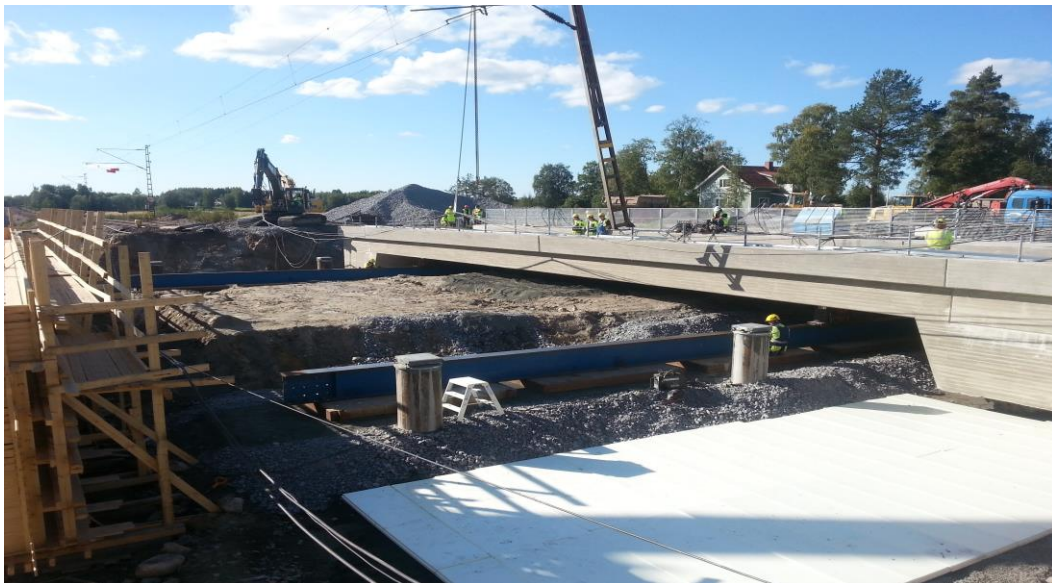
Kuvio 1. Sillan siirto tunkkausmenetelmällä.
