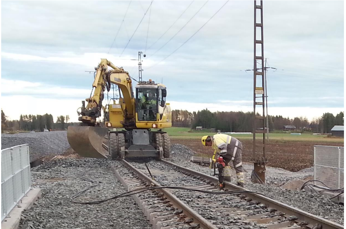
Kuvio 7. Raiteen sepelöinti kiskopyöräkaivinkoneella.
