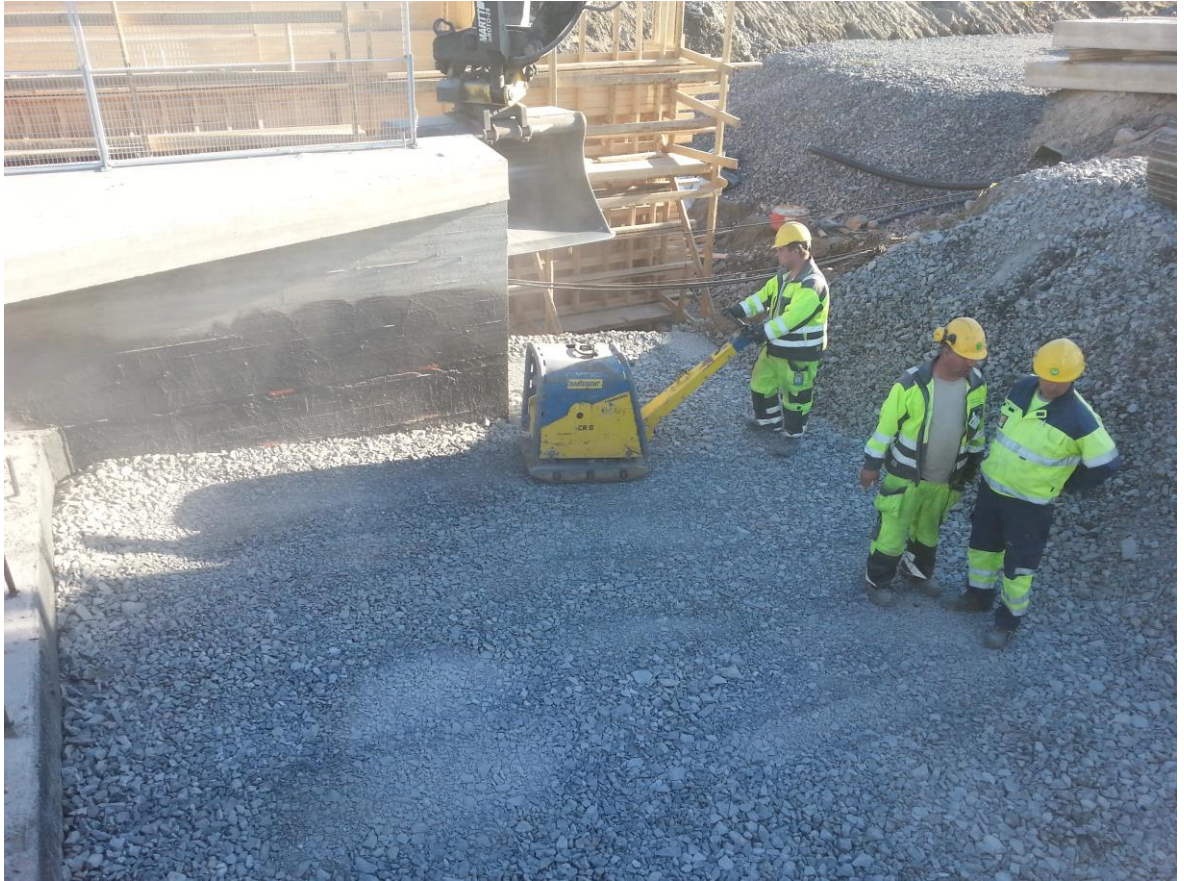
Kuvio 6. Siirtymälaittojen pohjien tiivistys tärylevyllä.
