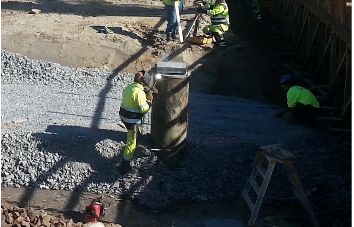
Kuvio 11. Laakerin aluslevyn hitsaus pilariin.
