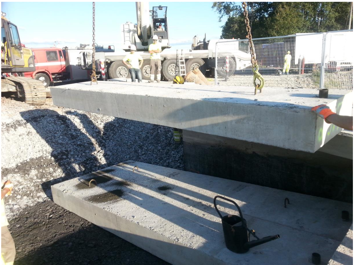
Kuvio 9. Siirtymälaattojen asennus autonosturilla.
