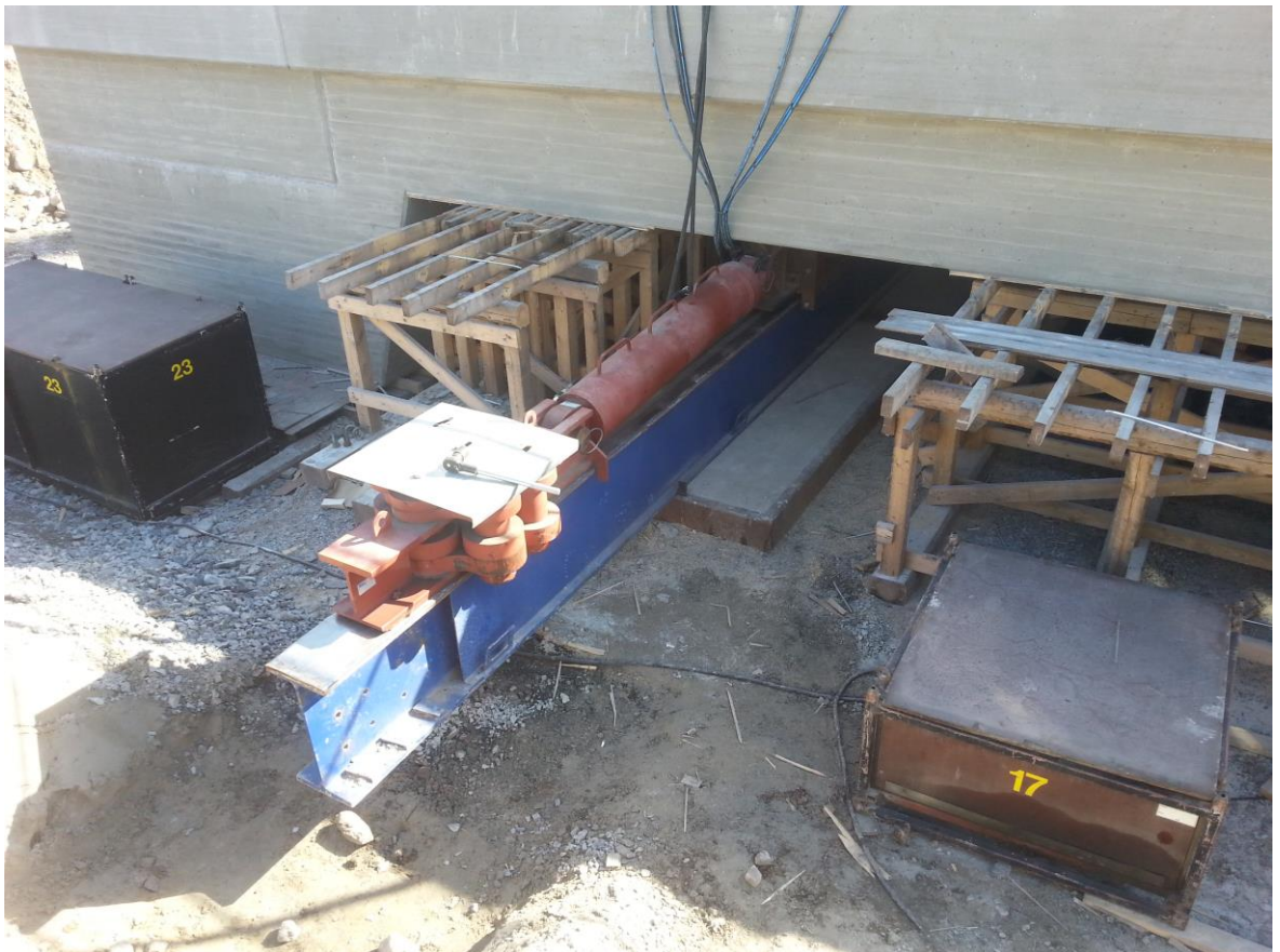
Kuvio 4. Muotti ja teline purettu ja valmisteltu siirtoa varten.
