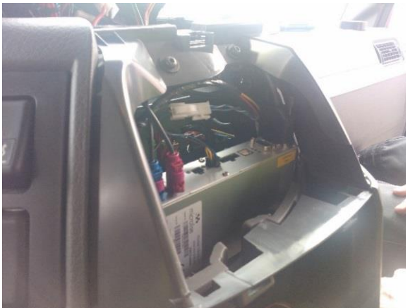
Kuva 7 MTU-3 yksikön asentaminen
