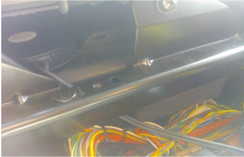
Kuva 6 GPS antennin asennus
