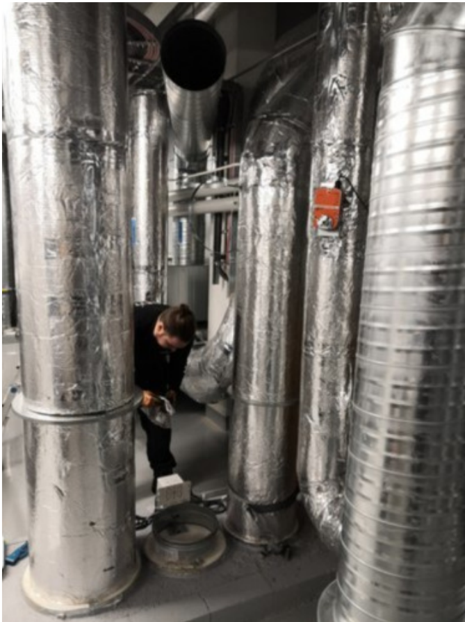
KUVA 13 Rikkoontuneen palopellin uusiminen TK02:lta lähtevään 315 tuloilmakanavaan
