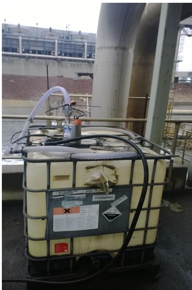
Kuva 8. Flokkulantin sekoitus- ja annostelulaitteisto.
