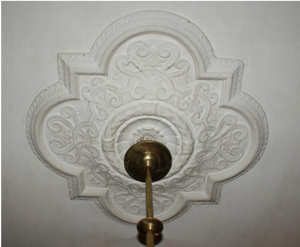
Kuva 34. Villa Svean olohuoneen rosetti.
