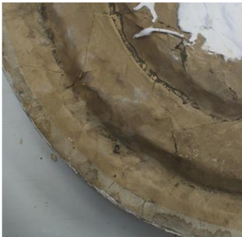
Kuva 19. Yksityiskohta paperisuikaleista laminoimalla valmistetusta kattorosetin taustasta.
