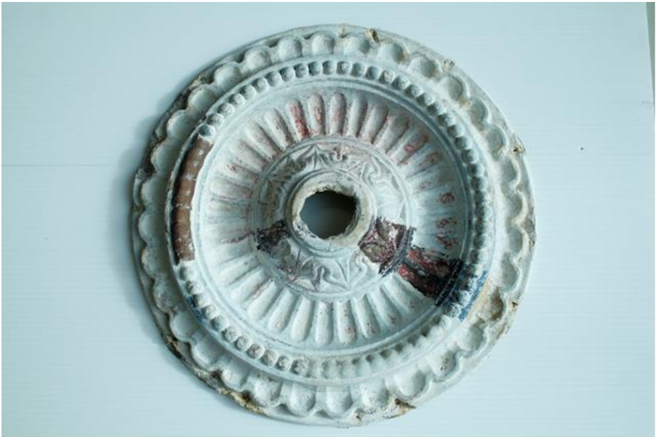
Kuva 35. Haminan Tanelinkulman kulmahuoneen paperirosetti ennen restaurointia.
