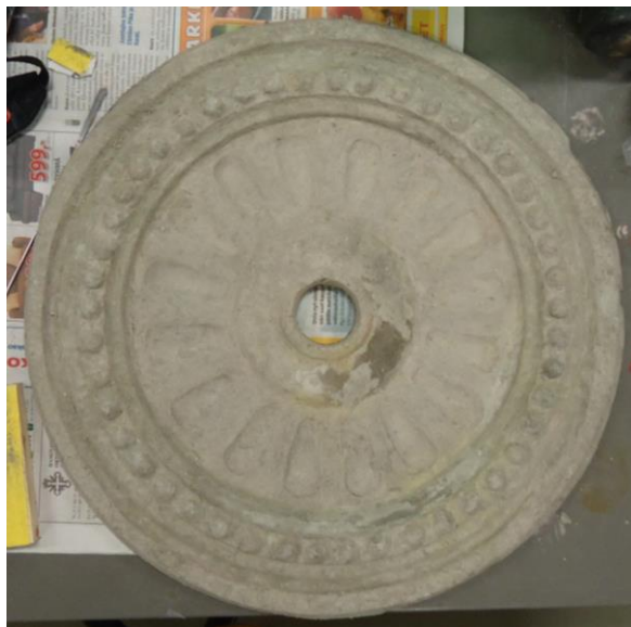
Kuva 52. Kuivunut ja paikattu valos.
