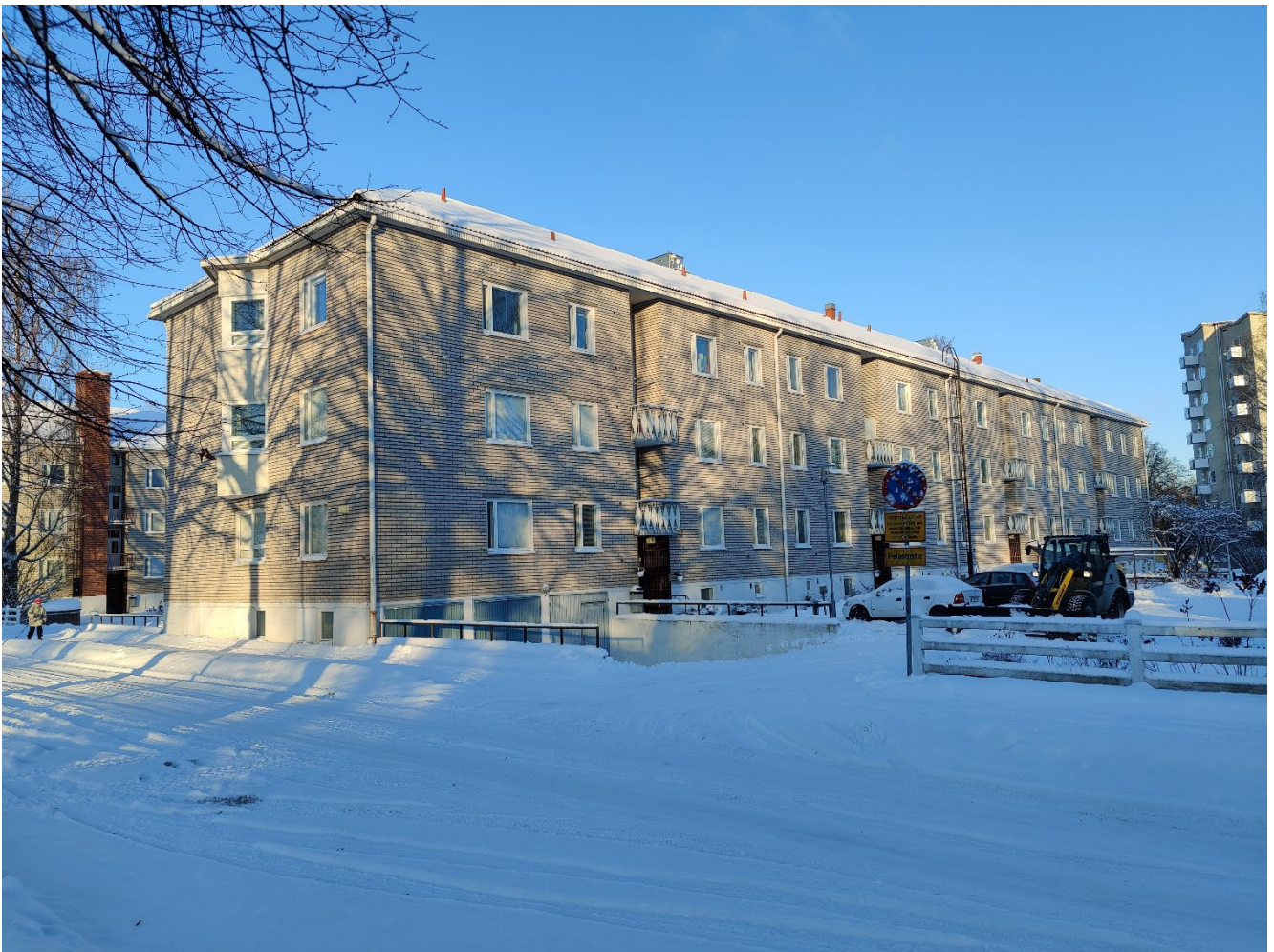
KUVA 1. Parolantiellä Hämeenlinnassa 1950-luvulla rakennettu kerrostalo.
