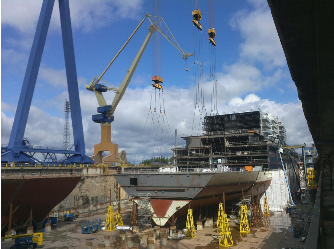
Kuva 4. Suurlohkon asentaminen STX Finland Oy:n Turun telakalla rakenteilla olevan Mein Schiff 3:een pukkinosturin avulla.
