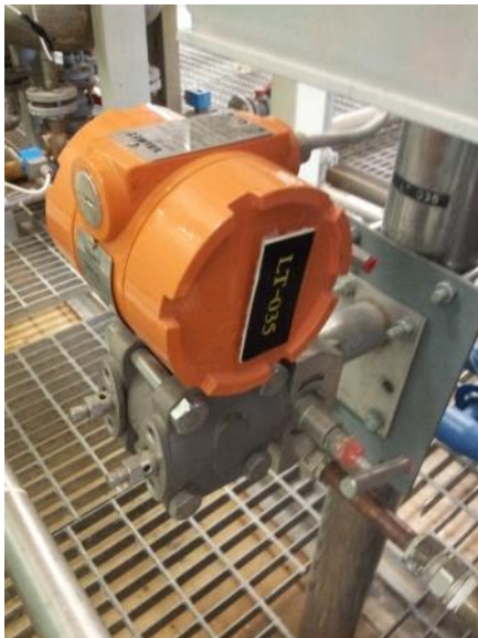
Kuva 19. Säiliön SL4 pinnankorkeudenlähetin
