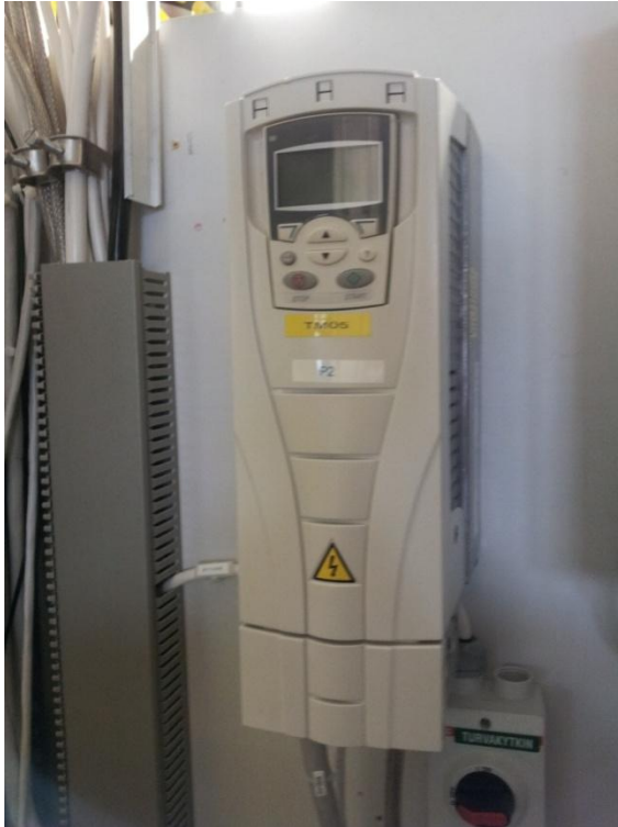
Kuva 4. Osaprosessin SL4 taajuusmuuttaja ABB ACS550
