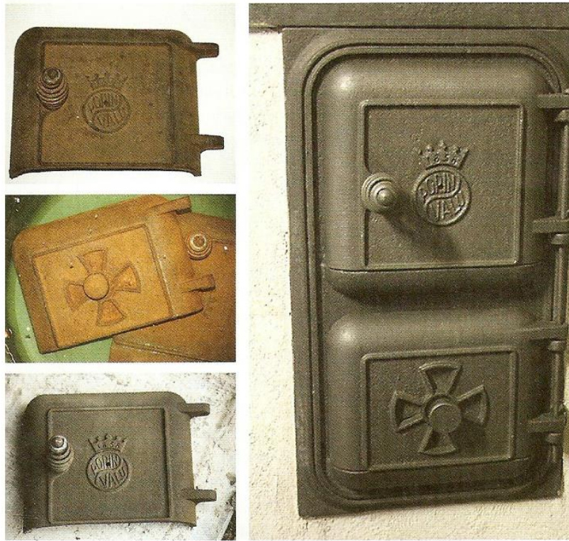
Kuva 12. Vasemmalla ylhäältä alas puhdistamaton luukku, luukut sitruunahappoliuoksessa ja luukku liotuksen jälkeen. Oikealla grafiittikäsitellyt luukut. (Fagerlund 2012, 61.)
