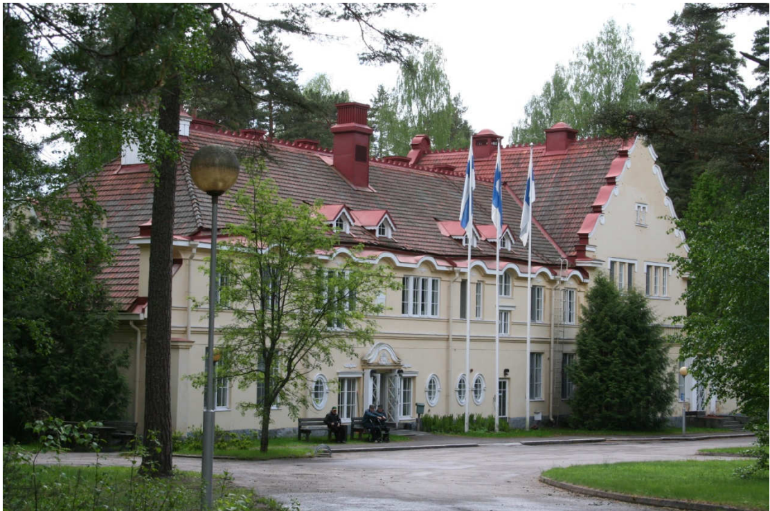
KUVA 2. Entinen hotelli Finlandia, nykyinen hoitokoti Finlandia (Kruunupuisto Oy 2009)
