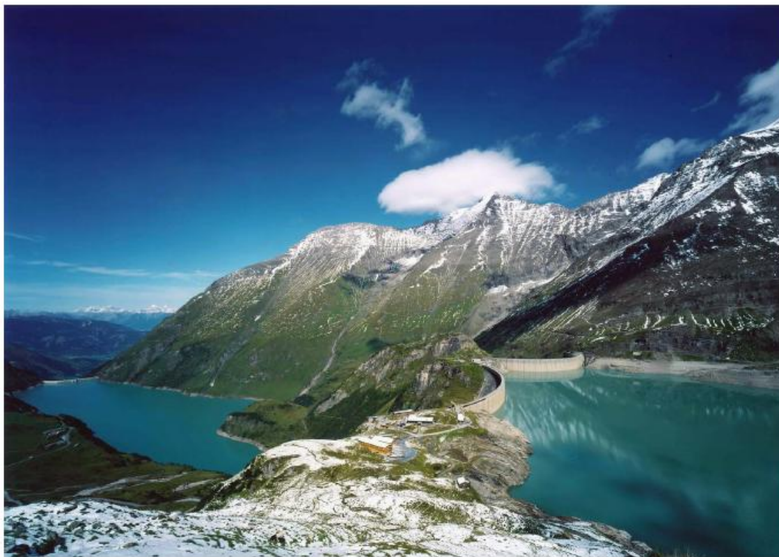
Kuva 5. Pumppuvoimalaitos Limbergissä Itävallassa [13, s. 15]
