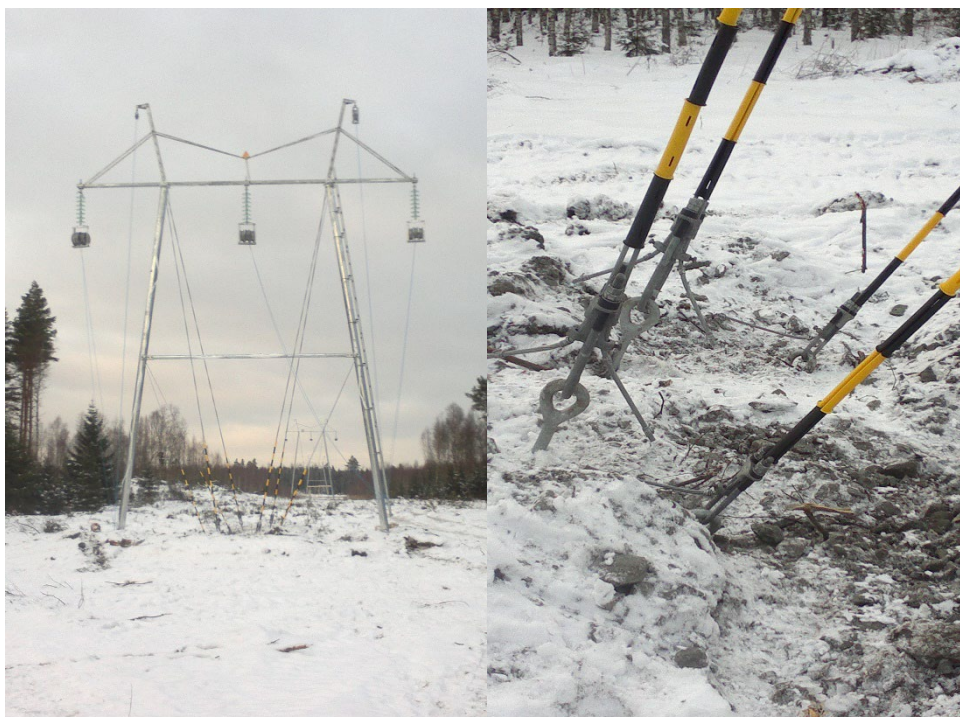
KUVA 1. Alkuperäinen kiristin asennettuna (Tiihonen 2021)
