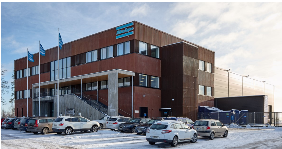
Kuva. 1. Atlas Copco Suomen pääkonttori Vantaa Hakkila 2015 (Atlas Copco)
