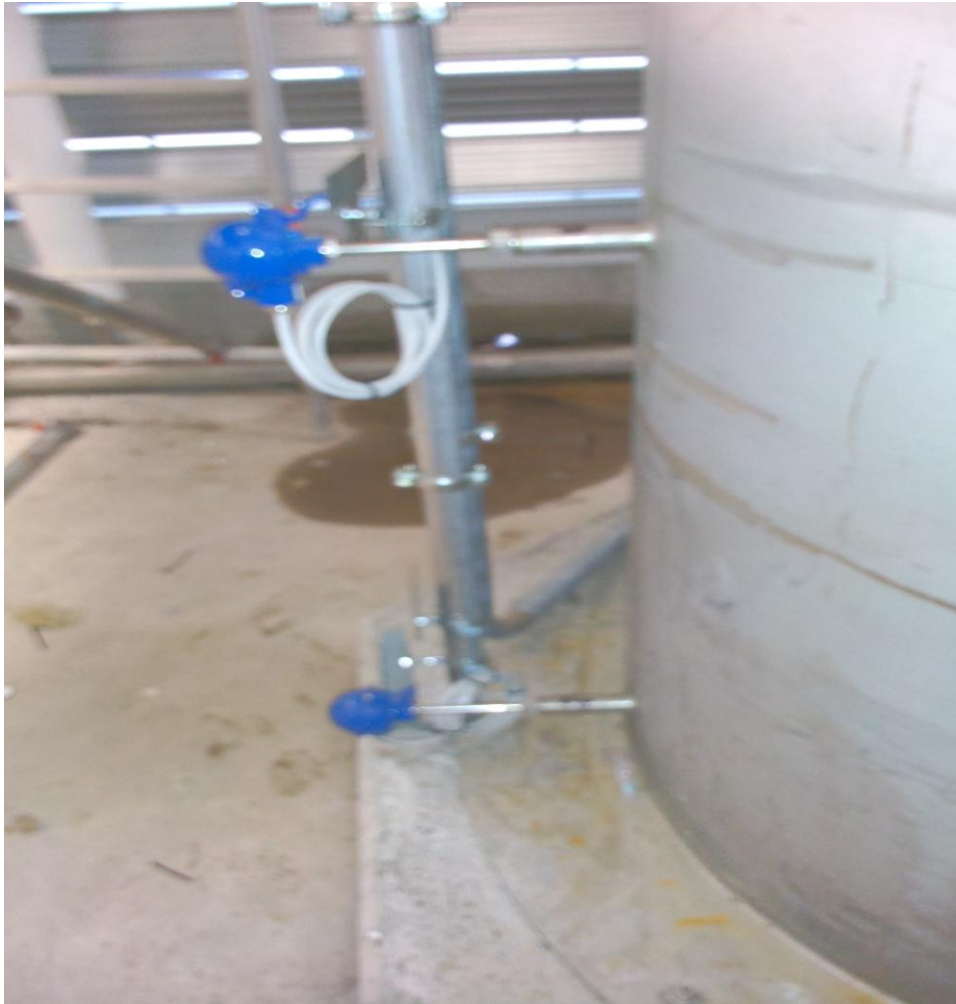
Kuva 9, Pt-100 höyrystimessä
