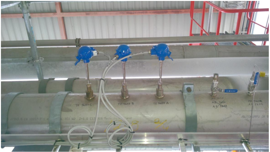
Kuva 7, lämpötila-anturit TT5607A-C
