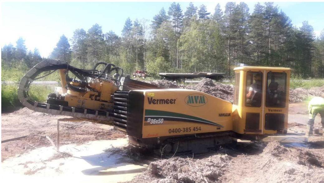
KUVA 14. Suuntaporaukseen käytetty poravaunu työmaalla (Tuomaala 2021)
