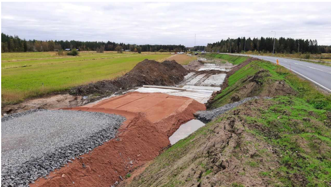
KUVA 13. Rakennekerrosten rakentamista työmaalla (Tuomaala 2021)
