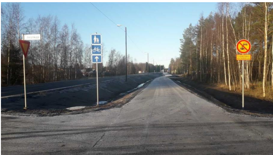
KUVA 16. Valmis kevyen liikenteen väylä (Tuomaala 2021)
