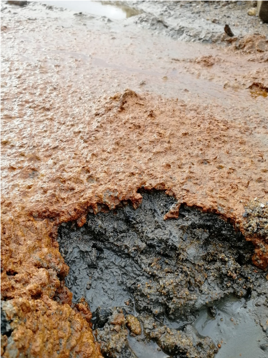
Kuva 3. Hapettunut pintakerros on muuttunut mustasta kuparinruskeaksi.
