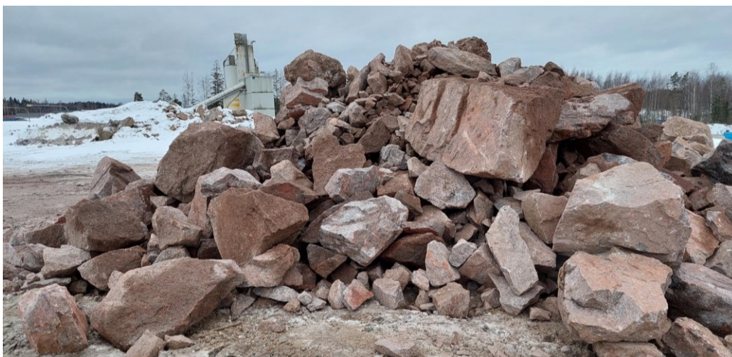
Kuva 15 Louhekuormat purettuna penkan päällä. (Kuva: Aki Rouvinen)
