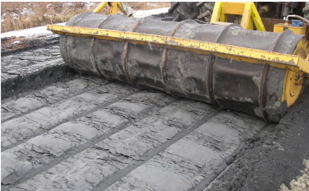
Kuva 9. Kurjennevan koekenttälueen stabilointi.
