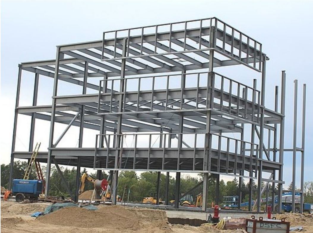
Kuva 4. Teräsrunkohalli runkorakennusvaiheen jälkeen. (burdette, 2013 )
