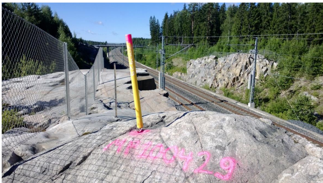
Kuva 14. Kuvassa on kiintopiste, joka on rakennettu asianmukaisesti [Kuva: Janne Rantala ©].
