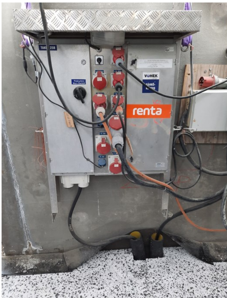
KUVA 17. 125A pääalakeskukset omilla virransyötöillä (Kouhia 2022)
