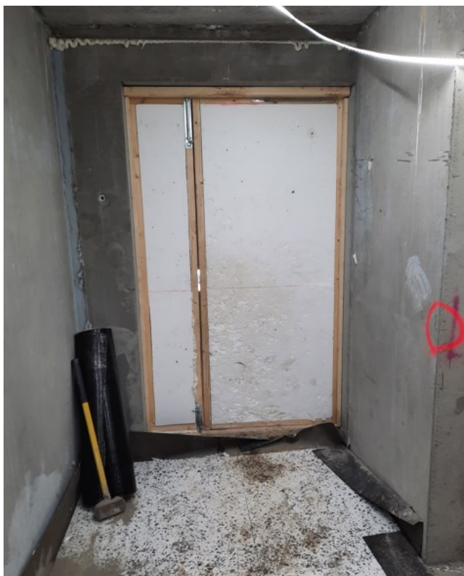
KUVA 12. Väliaikainen ulko-ovi (Kouhia 2022)
