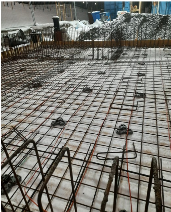
KUVA 5. VSS lattian lämpölangat (Kouhia 2021)
