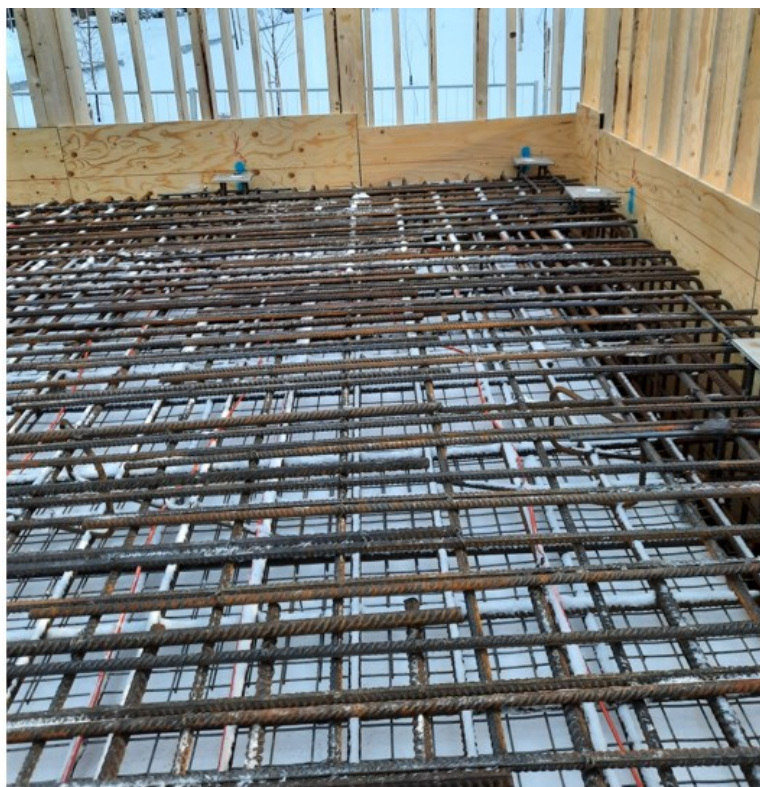
KUVA 6. Väestösuojaan holvin lämmityskaapelit (Kouhia 2022)
