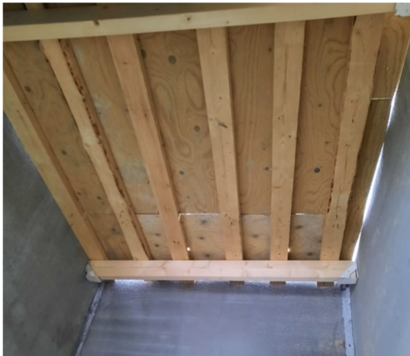
KUVA 16. Hissikuiluntaso alhaalta (Kouhia 2022)
