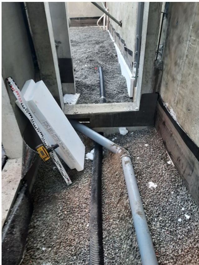
KUVA 10. Maatyöt käynnissä (Kouhia 2022)
