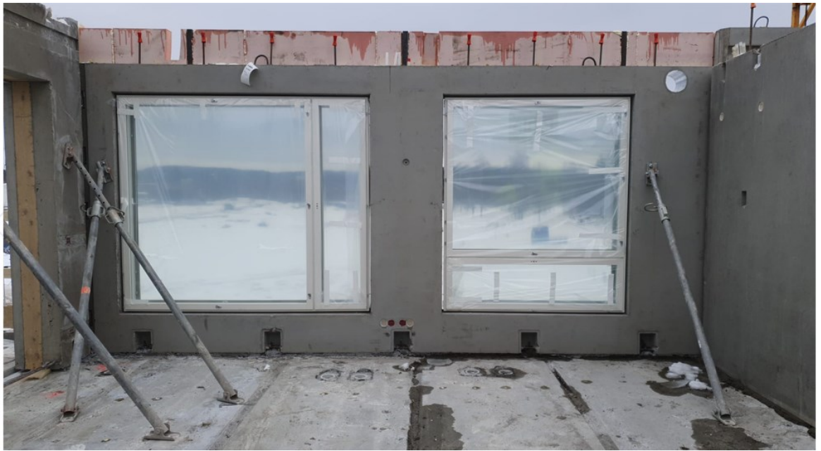
KUVA 15. Ikkunat asennettu (Kouhia 2022)
