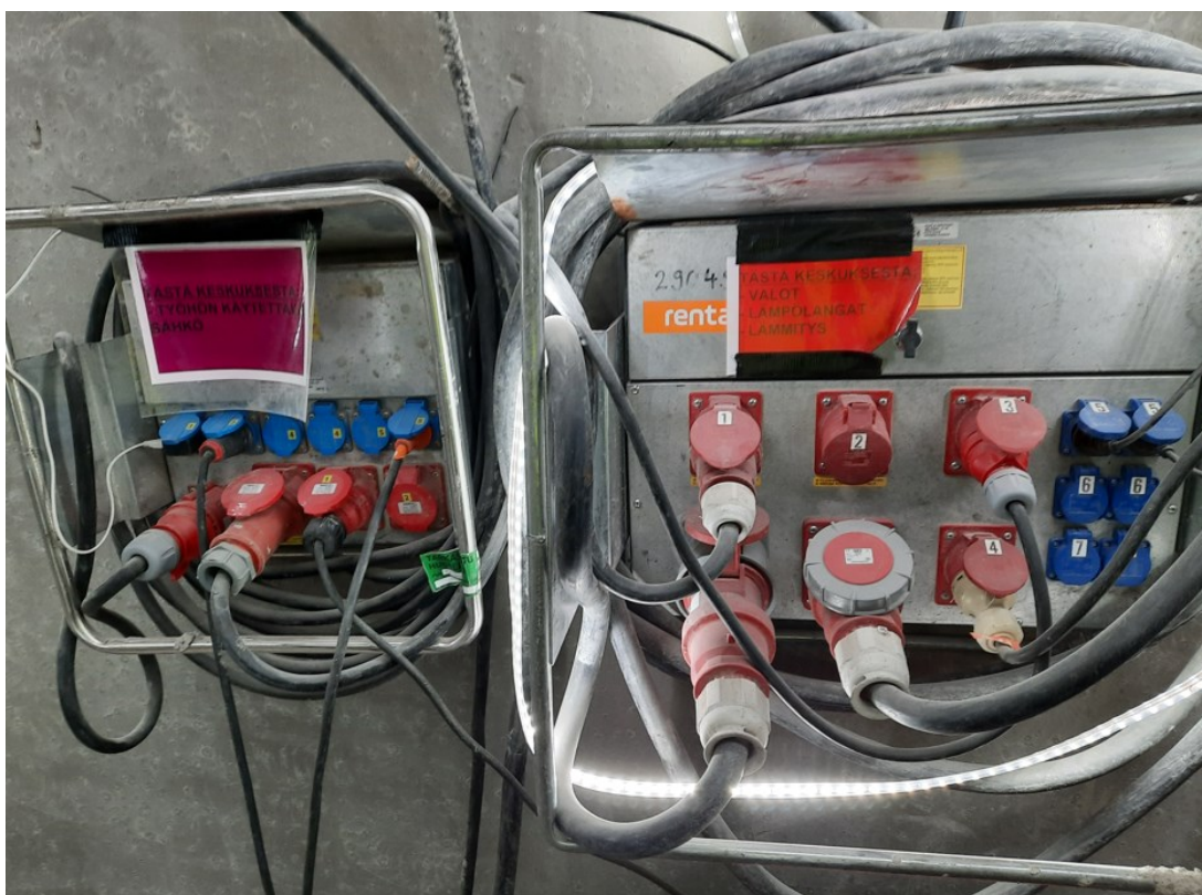
KUVA 18. Alakeskuksien käyttötarkoitukset kylteissä (Kouhia 2022)
