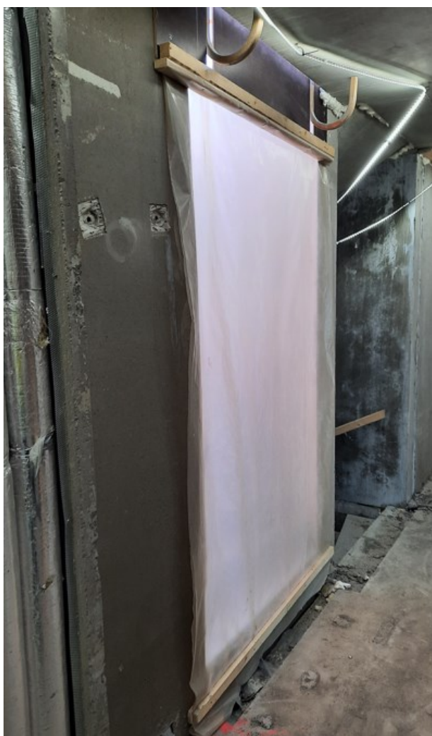
KUVA 12. Väliaikainen ulko-ovi (Kouhia 2022)
