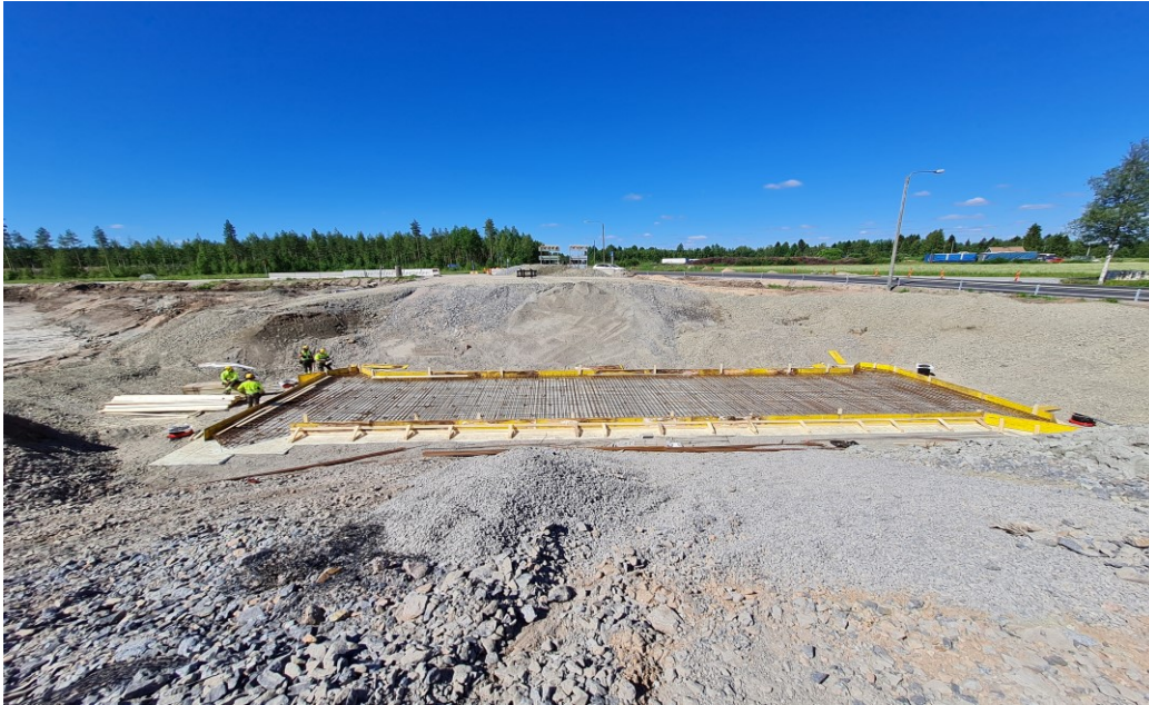
KUVA 8. Sillan pohjalaatan muotti
