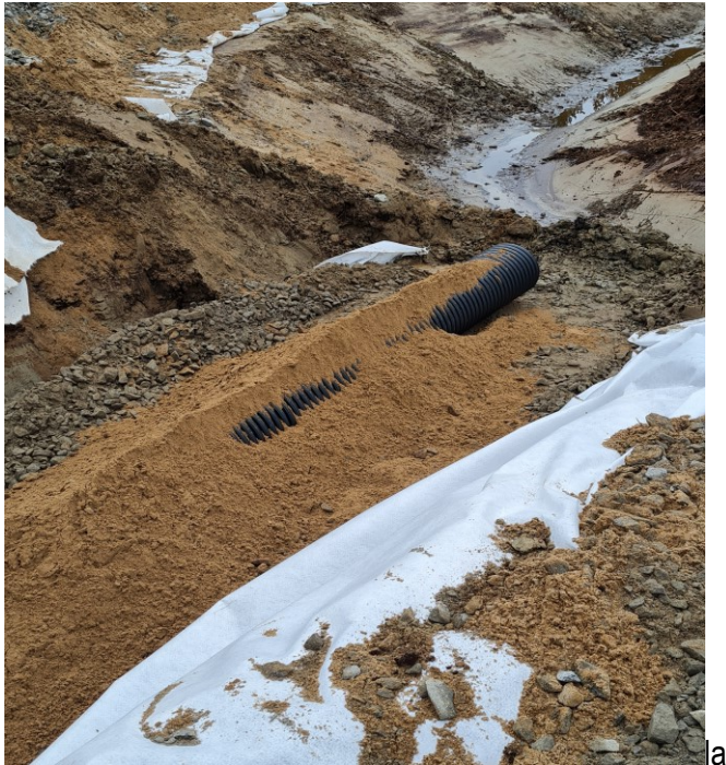
KUVA 4. Uuden rumpuputken asennus
