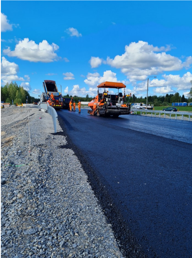
KUVA 9. Sillan kohdan asfaltointi
