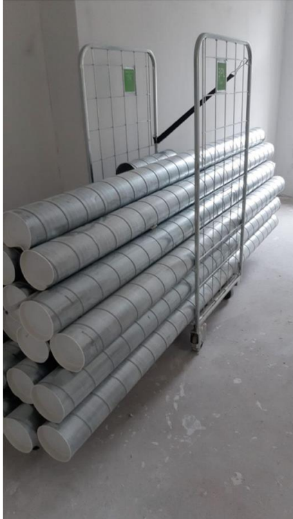
Kuva 9. Ilmanvaihtokanavaa siististi rullakossa.
