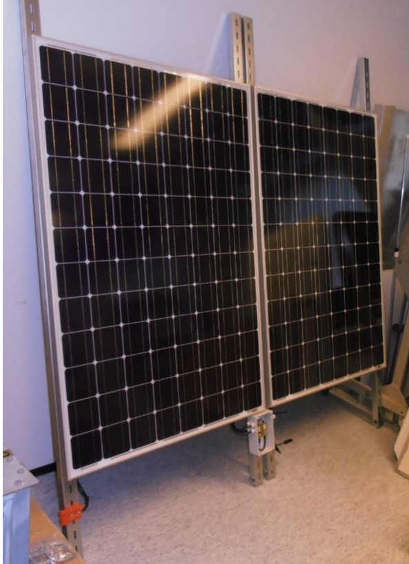
KUVA 15. Paneelit pakettiin rakennettuna
