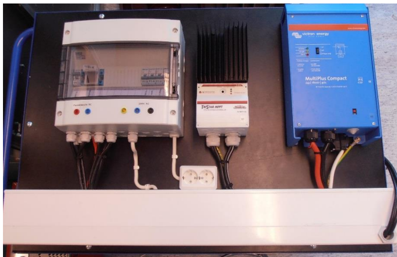
KUVA 9. Valmis kärry päältä
