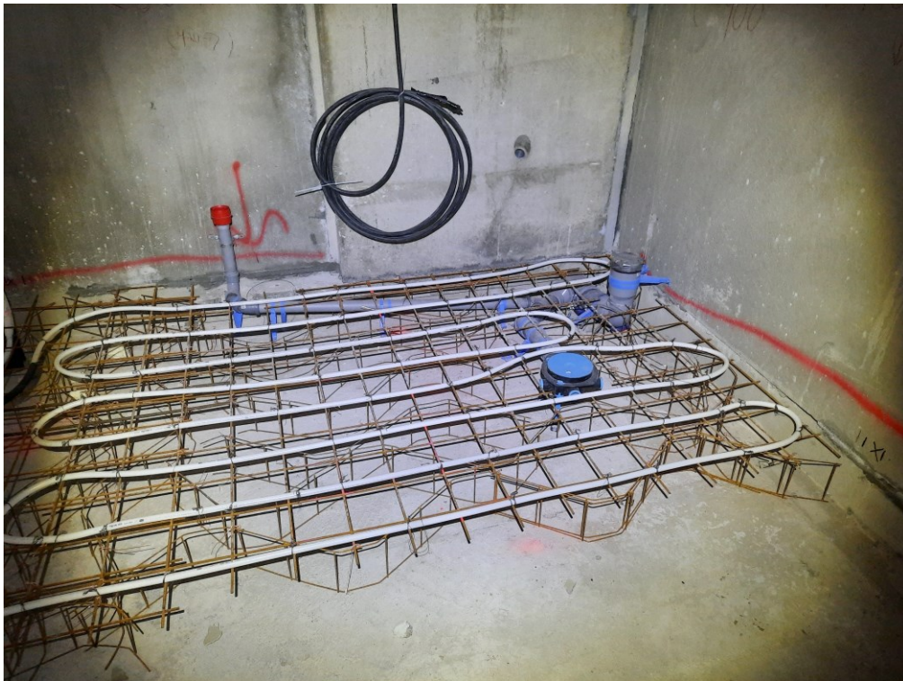
Kuva 2. Asunnon viemäröinnit, raudoitusverkko ja lattialämmityspotket asennettuna oikeaoppisesti. [2]
