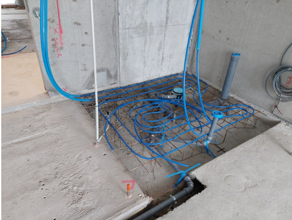
Kuva 5. Valuvalmis kylpyhuone. Talotekniset työt on tehty ja alustan kuivuudesta on huolehdittu. [8.]
