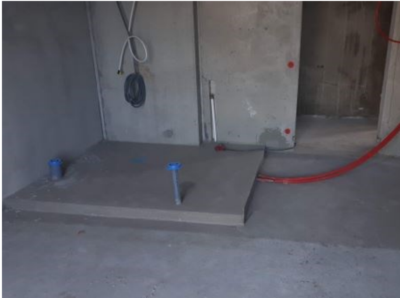
Kuva 3. Valmis kaatolattiavalu on suorareunainen ja kaadot suuntautuvat lattiakaivolle. [2]
