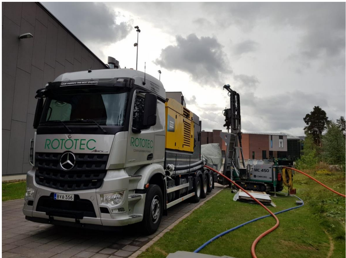
Kuva 2. Porauskalustoa poraamassa energiakaivoa. Kompressoriatosta siirretään paineilmaletkujen avulla poravaunulle poraamiseen vaadittavaa paineilmaa. (7.)
