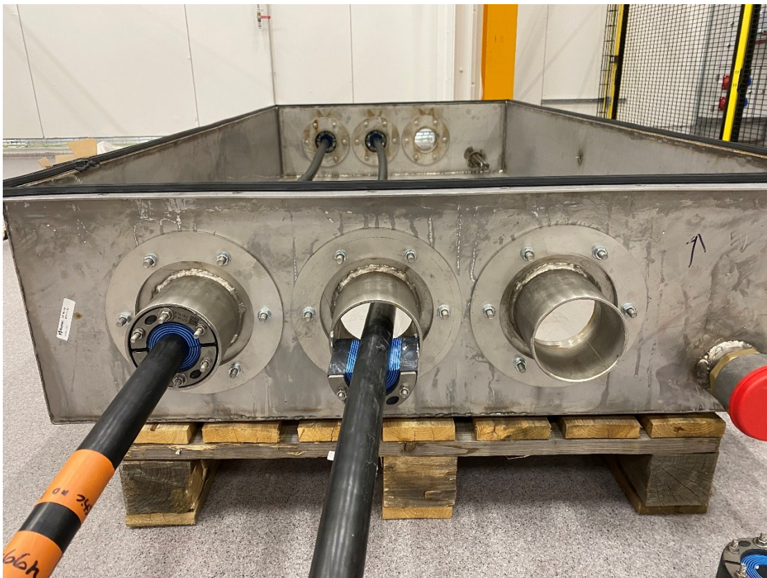
Kuva 16. Testattavien kaapeleiden asennus altaaseen.
