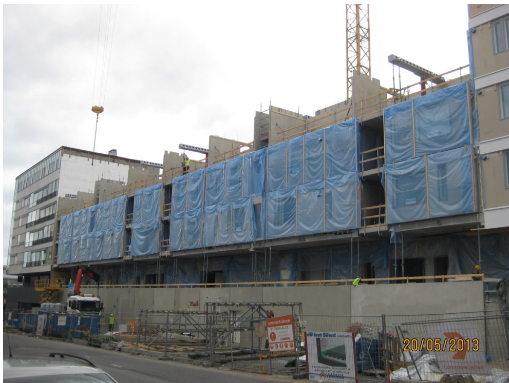
Kuvio 1. As Oy Jyväskylän Väinönkatu 15 rakenteilla
