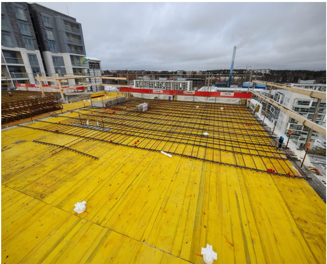
Kuva 3. Holvin pohjaraudoitus aluillaan.
