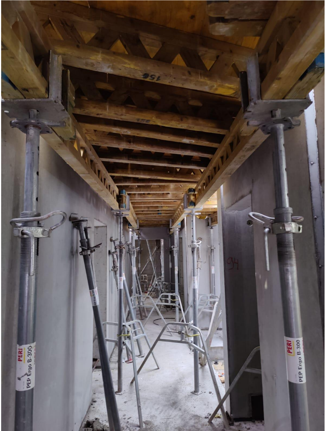
Kuva 2. Työmaalla käytetty muottijärjestelmä.
