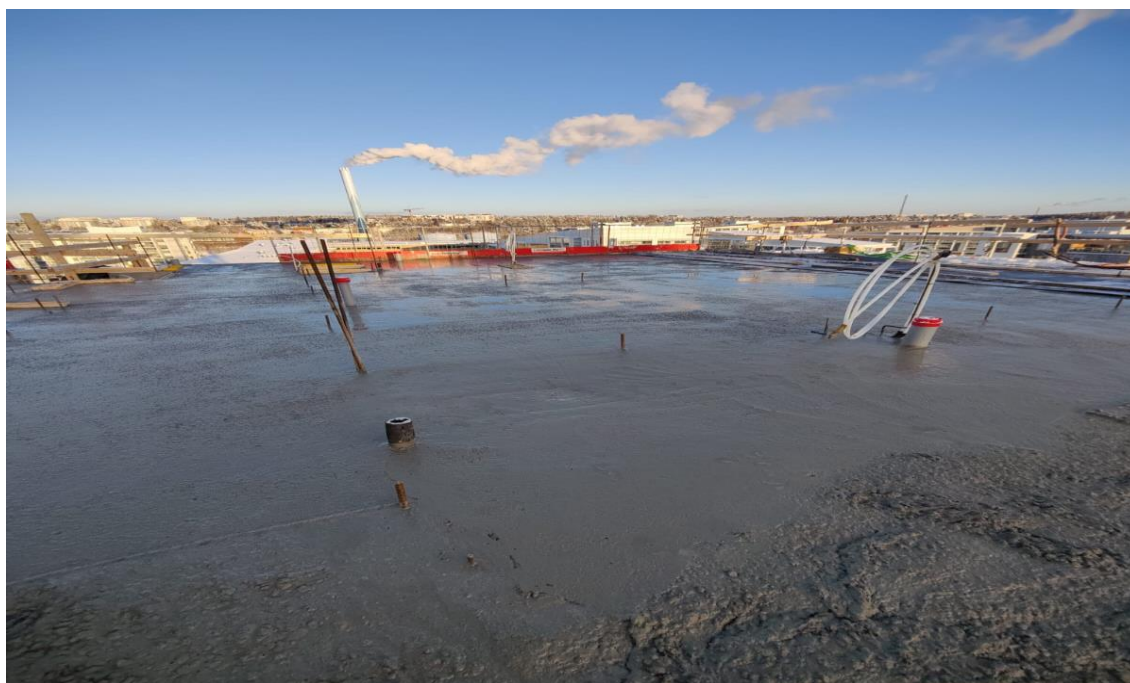
Kuva 8 Kuva keskeneräisestä valusta.
