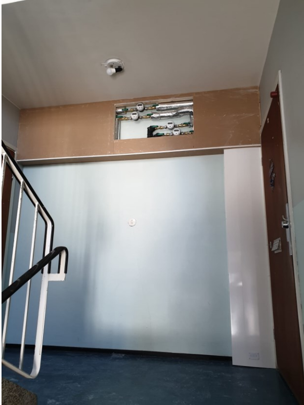
KUVA 12. Porraskäytävän kotelot pintakäsittelyä vaille valmiina
