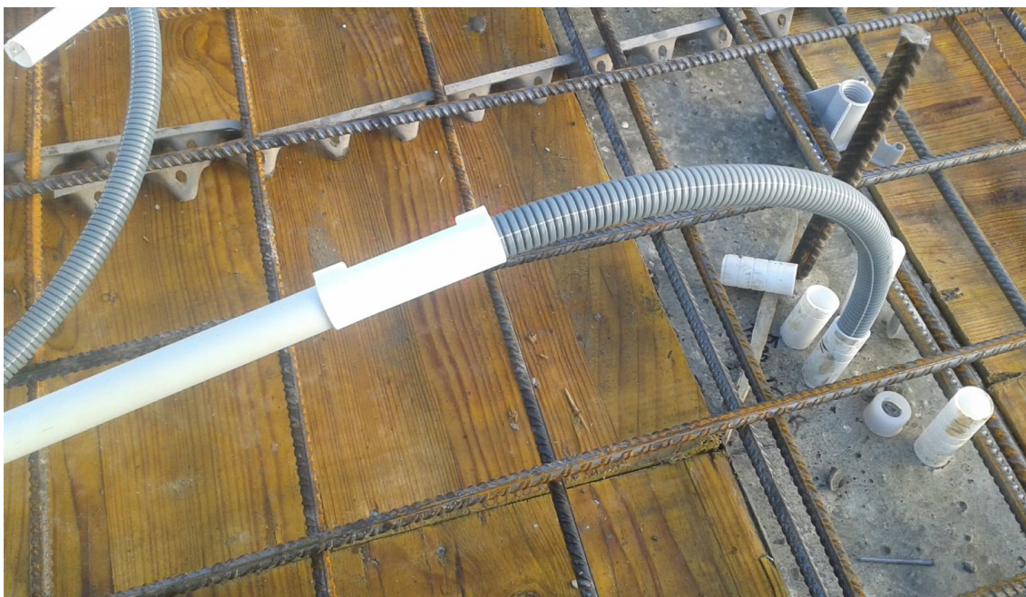
Kuva 4. Hyvä seinäelementin putkitus.
