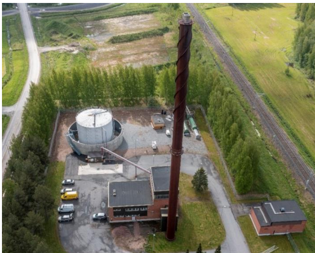
Kuva 5. Ulsoorin kaukolämpökeskus. (Pori Energia kuvadokumentti, 2021)
