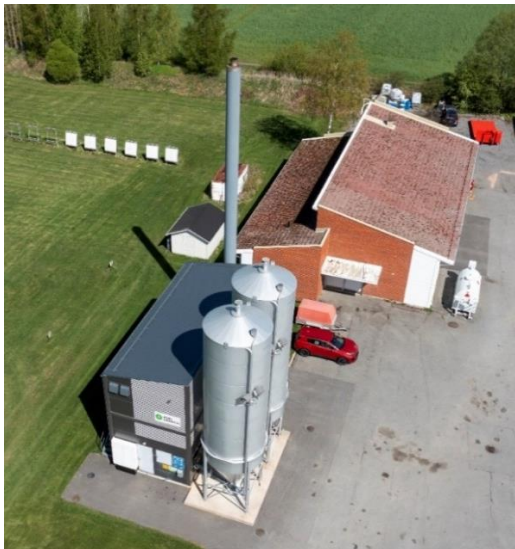
Kuva 6. Ulvilan pelastuslaitoksen kaukolämpökeskus. (Pori Energia kuvadokumentti, 2021)
