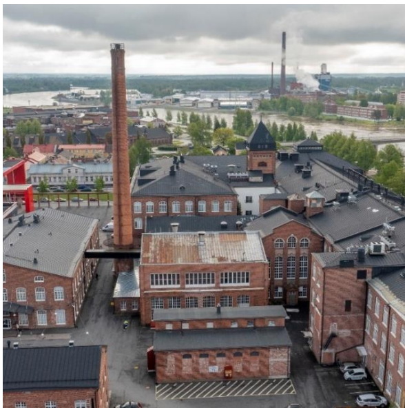
Kuva 4. Puuvillan kaukolämpökeskus. (Pori Energia kuvadokumentti, 2021)
