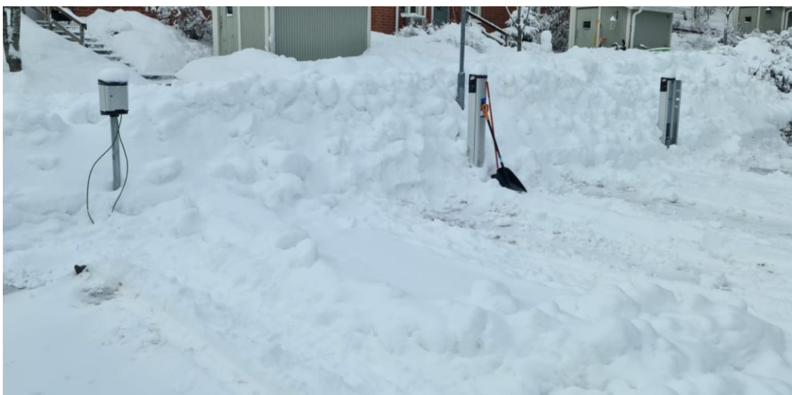
Kuva 9. Sähköauton latauspisteet maahan asennettuna.
