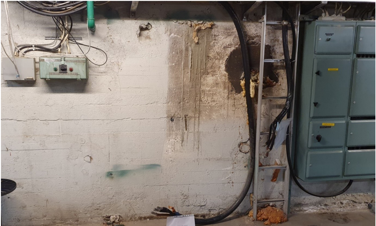
Kuva 12. Seinä vanhan keskuksen purkamisen jälkeen.
