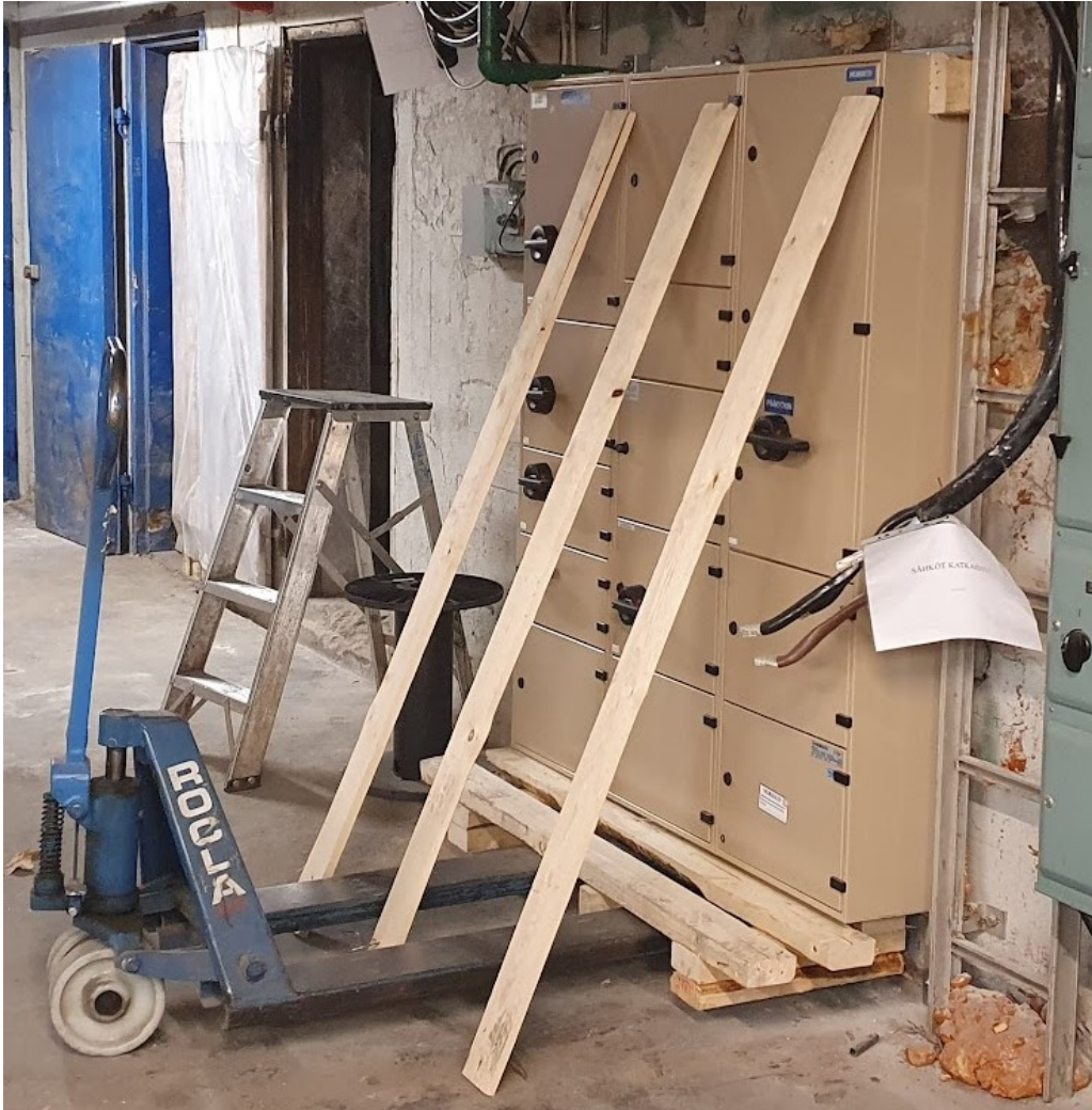
Kuva 14. Uuden keskuksen asennus.
