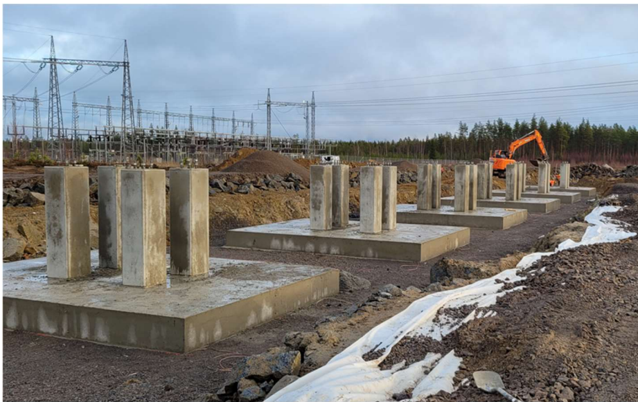
Kuva 5. Alajärven sähköaseman 110kV kentän portaaliperustukset.
