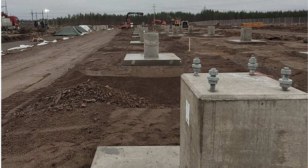
Kuva 6. Alajärven sähköaseman 110kV kentän virtamuuntajien perustukset.
