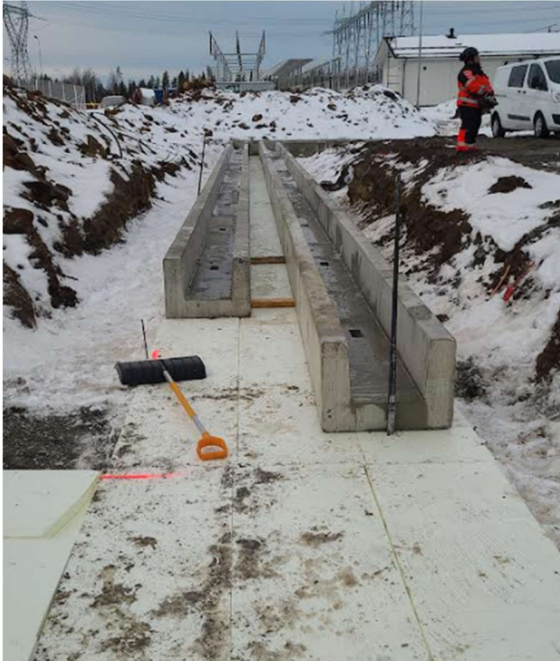
Kuva 7. Alajärven sähköaseman K9 kaapelikanavien asennus XPS eristeen päälle.
