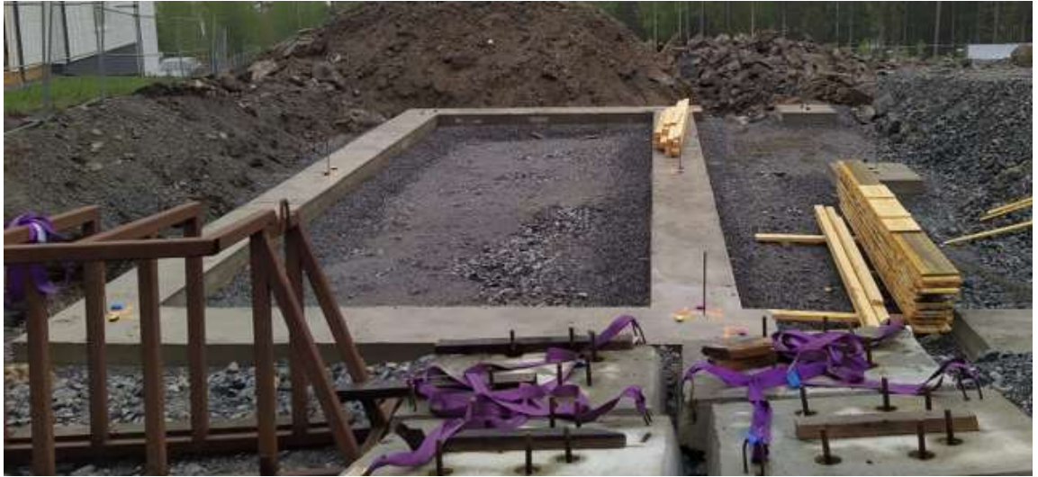
KUVA 9. Valmiit perustukset (Haaranen 2022)
