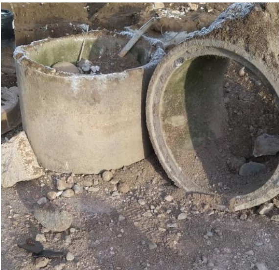
KUVA 3. Vanhat betonikaivot kaivettiin ylös
