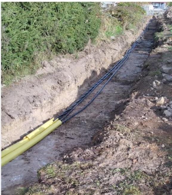
KUVA 5. Vanhan koulurakennuksen vieressä olleen sähkökaapelin siirtäminen
