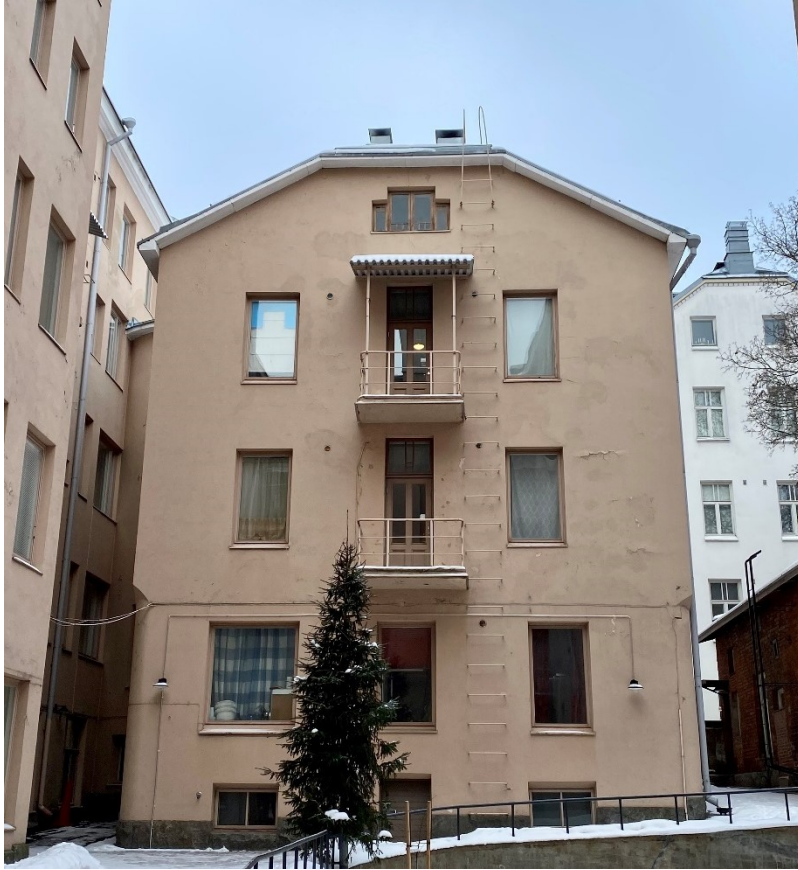
Kuva 15. Kohde sisäpihalta päin. Palotikkaat toimivat parvekkeellisten asuntojen varatienä.
