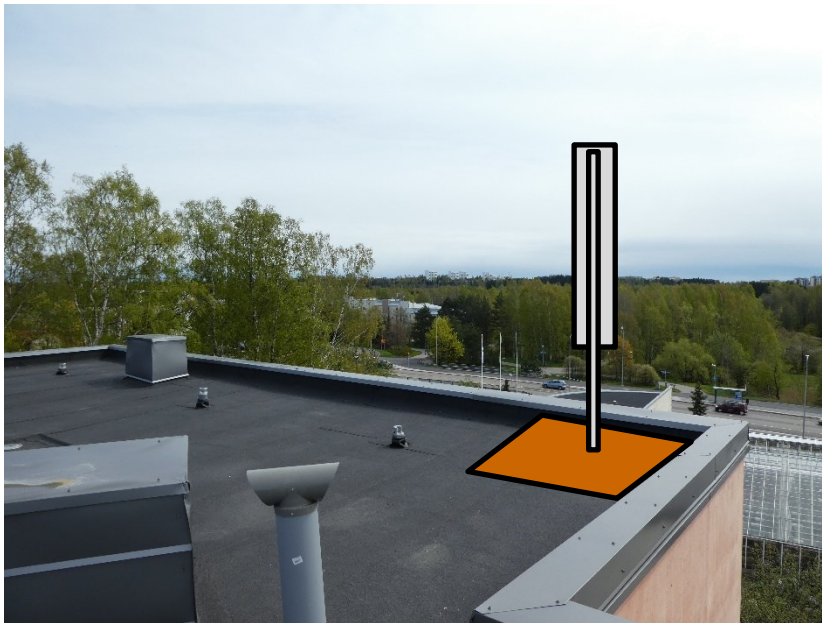
Kuva 4. Kiinteistön katolle suunnitellun ensimmäisen antennin asennuspaikka.
