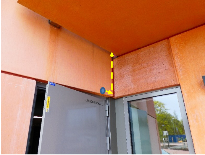
Kuva 8. Kaapeleiden läpivienti lämmönjakuhuoneesta kiinteistön seinälle.
