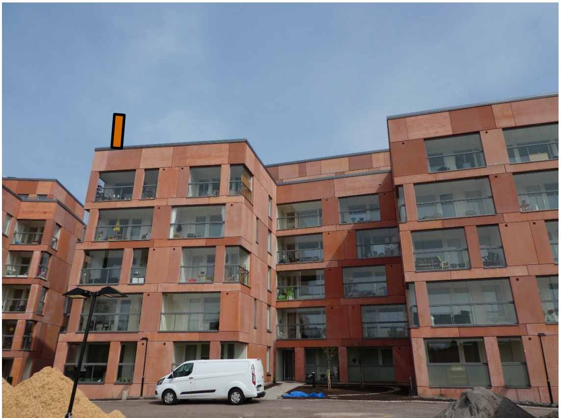
Kuva 6. Toinen antenni katsottuna kiinteistön sisäpihalta.
