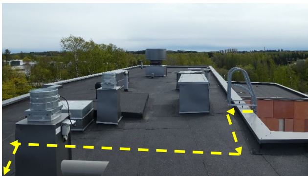
Kuva 12. Kaapelireitti antennille.
