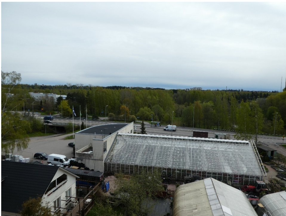
Kuva 2. Kiinteistön katolla pystytään katsomaan mahdollisia esteitä sekä suunnittelemaan antennien suuntausta.
