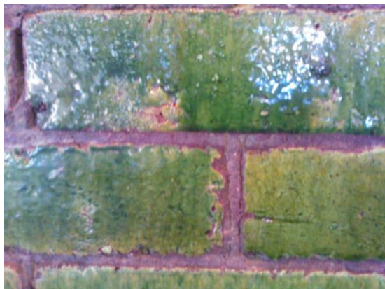
KUVA 53. Tiilien saumakohtat puhdistuksen jälkeen. (Jauho 2014)
