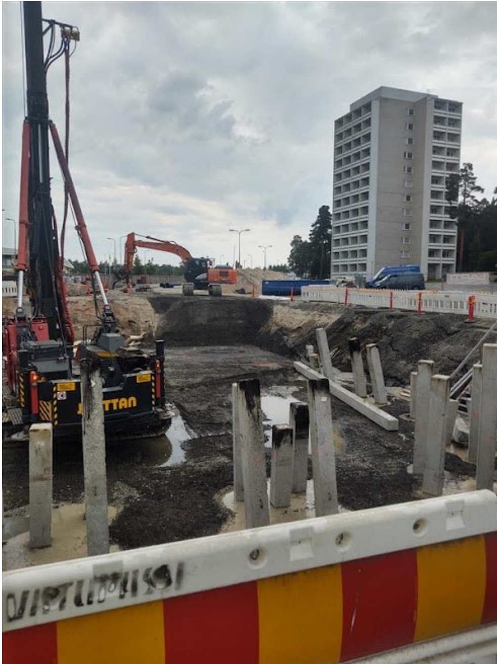
Kuva 10. Paalutustyömaa, jossa näkyy lyötyjä paaluja ennen katkaisua
