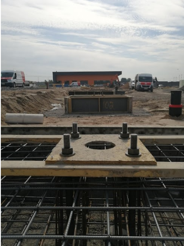
Kuva 16. Anturamuotteja, joihin asennettu pulttiryhmät paikoilleen
