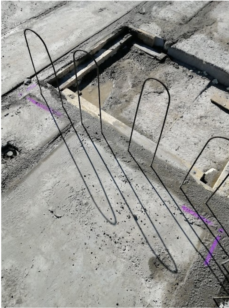
Kuva 19. Paikallaanvalettavan seinän nurkkamerkkejä ontelokentällä
