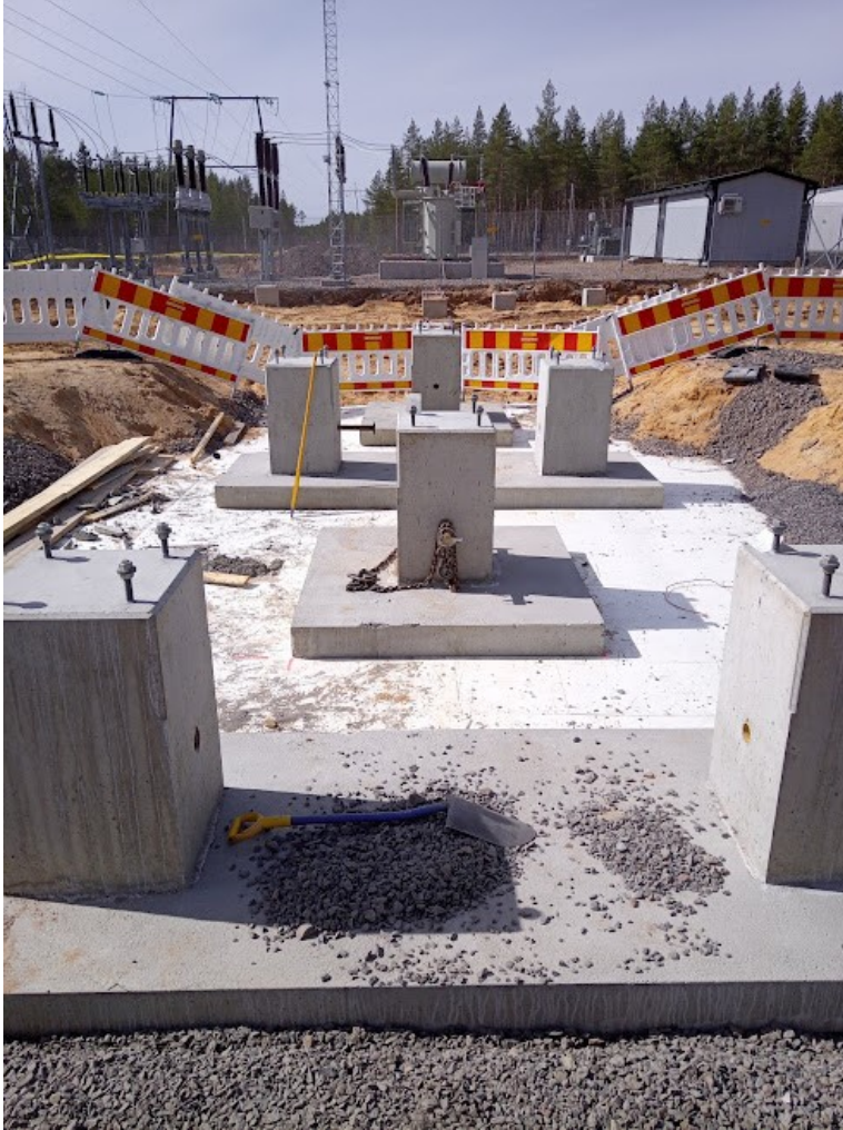
Kuva 17. Valmiit anturat pultteineen mitattuna paikoilleen
