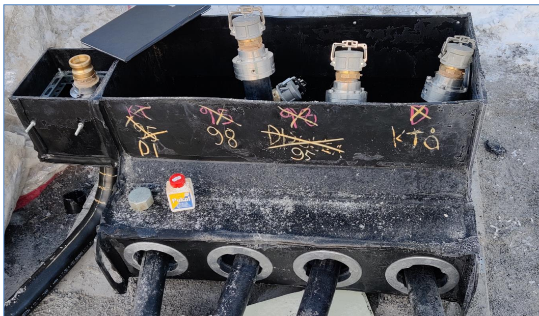
Kuva 24. Alareunassa näkyy läpivientikaulukset, vasemmalla varaimuputkelle tehty kaukalo.
