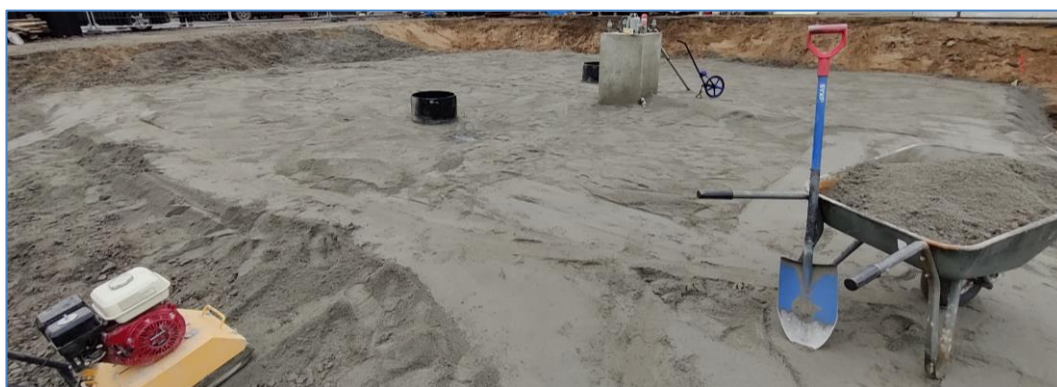
Kuva 16. Jakelualueen asennusalusta muotoilu ja tiivistys meneillään.
