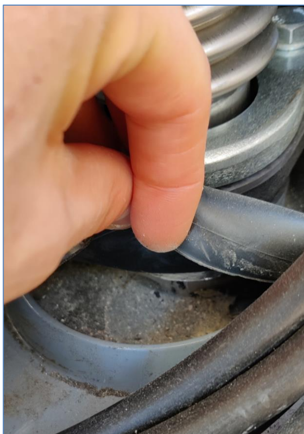
Kuva 29. Alareunassa näkyvillä laippaliitokset, josta jatkettu "kurttuputkella" mit-tarin suodattimille.
