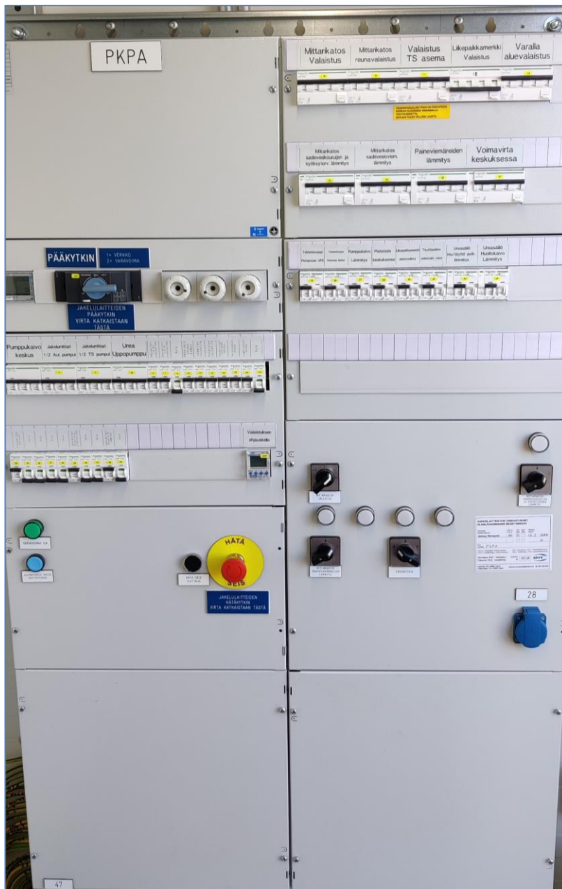
Kuva 37. Sähköpääkeskus laitetilassa.
