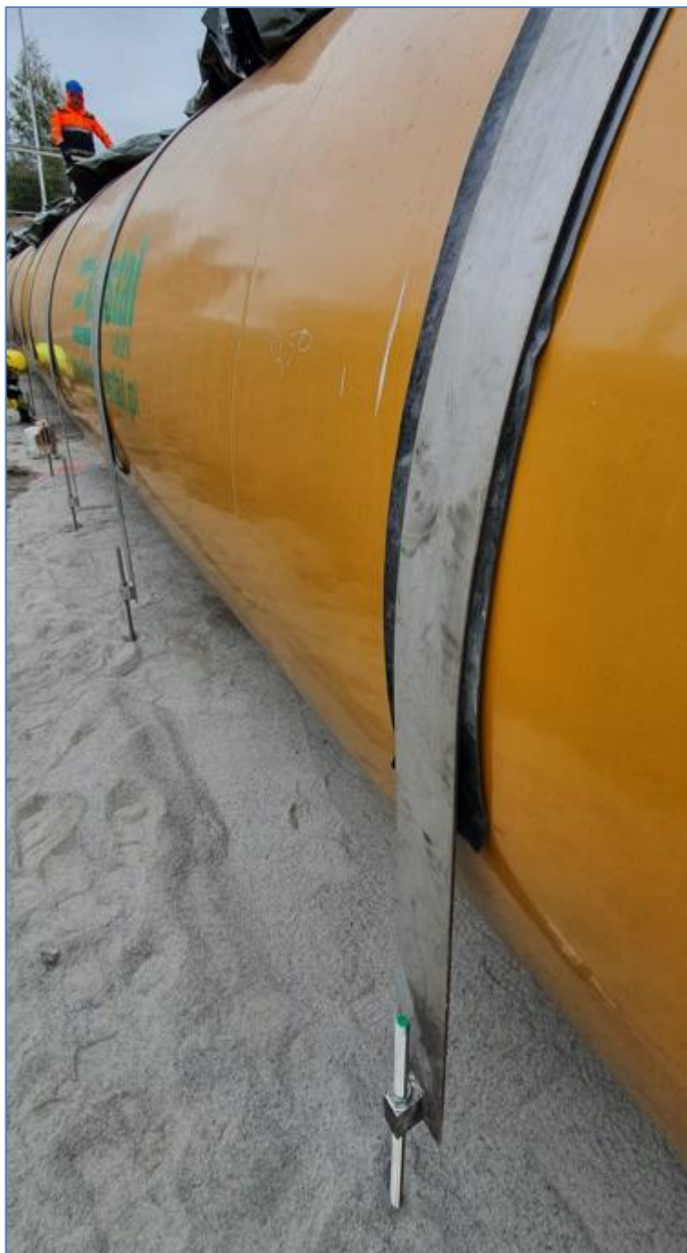
Kuva 5. Ankkurointipannan hankaussuoja, alhaalla näkyy myös ankkurointi laatasta nousema kierretanko.
