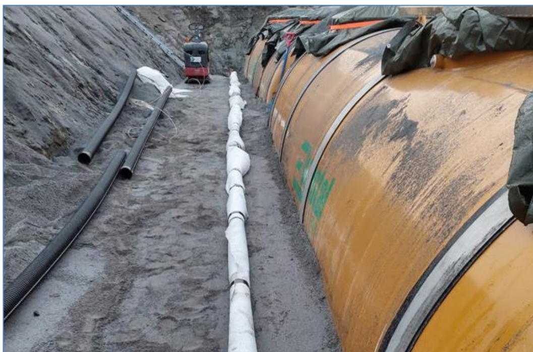
Kuva 9. Säiliökaivannon ylempi huokosilmaputki.
