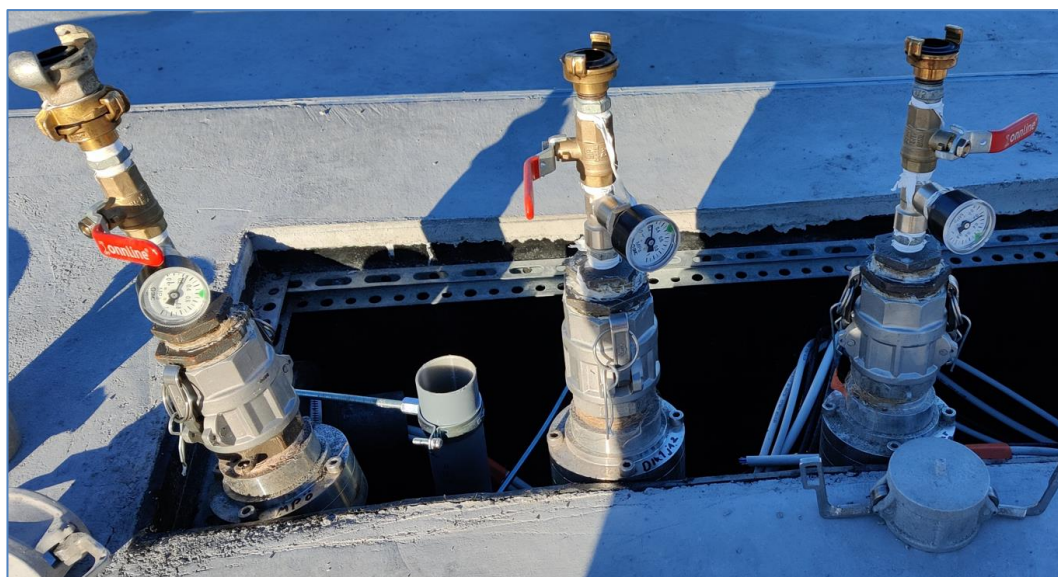
Kuva 25. Koko järjestelmän painekoe meneillään, imuputkien päähän asennettu painemittarit, joista seuranta tehdään.
