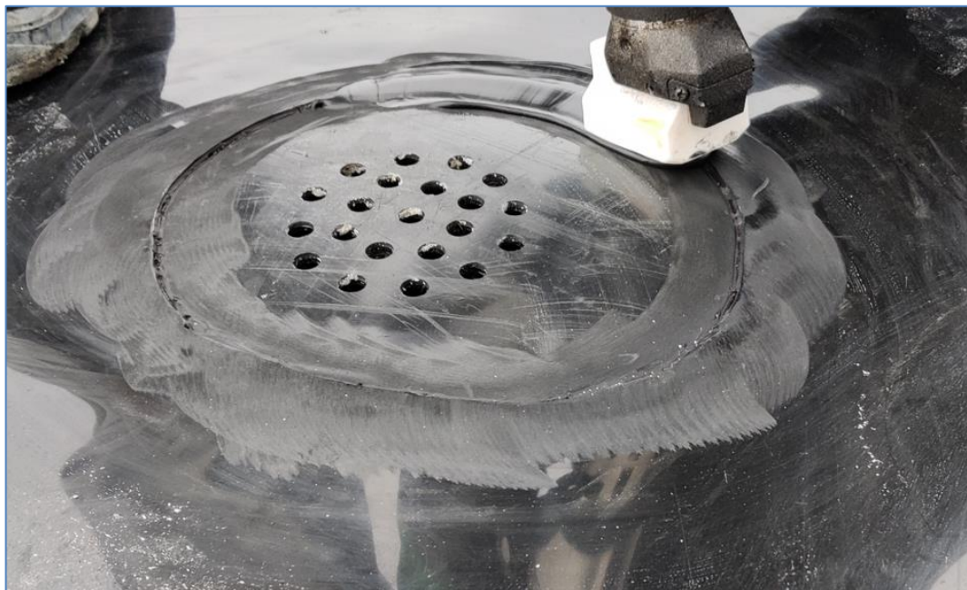
Kuva 19. Extrusiohitsaus meneillään, laite pursottaa sulaa muovia saumaan.
