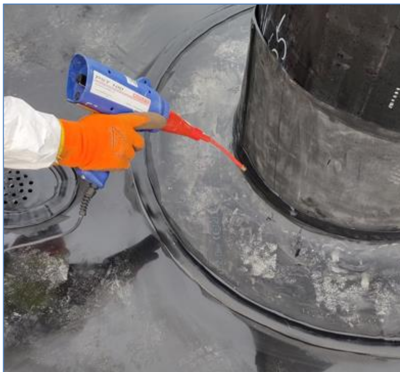
Kuva 20. Extrusiohitsatun sauman tiiveys todennettiin kipinäkokeella.
