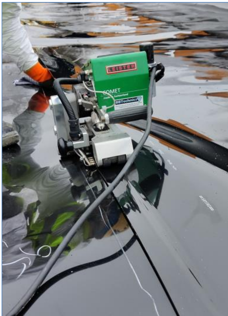
Kuva 17. Kuumakiilahitsaus meneillään.
