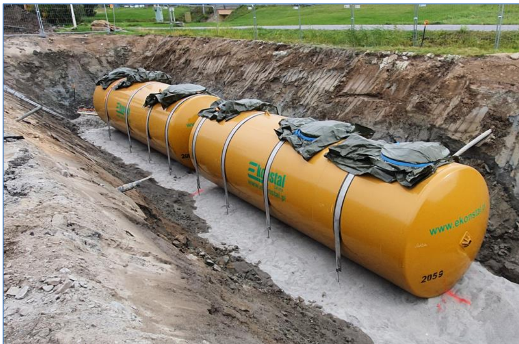
Kuva 4. Säiliöt asennettu kaivantoon.
