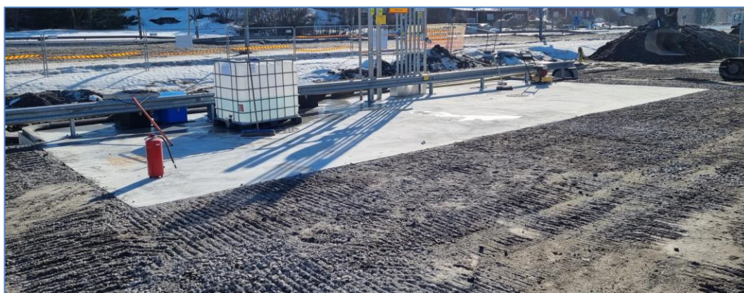
Kuva 28. Täyttöpaikan päällyste toteutettu betonilaatalla.
