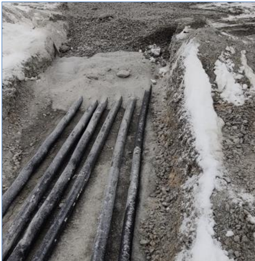
Kuva 23. Imuputkistoa, suojaiekkakerros ja kantava kerros.
