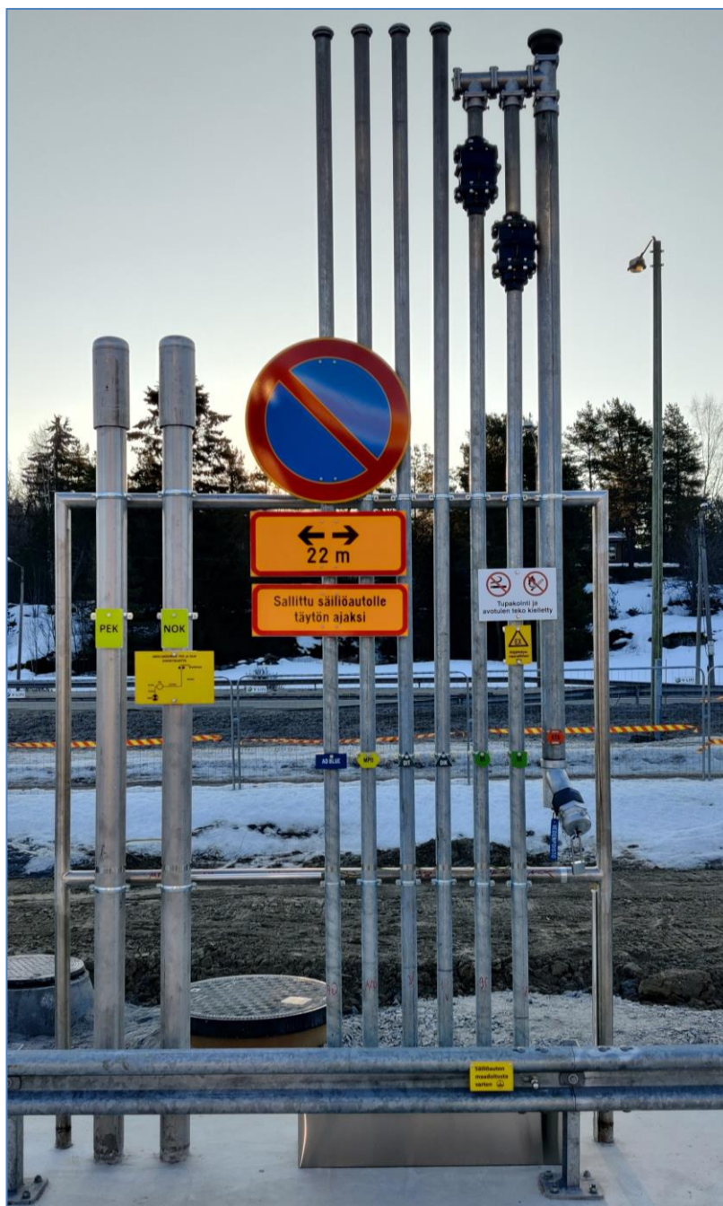
Kuva 34. Putkipatteriston merkinnät.
