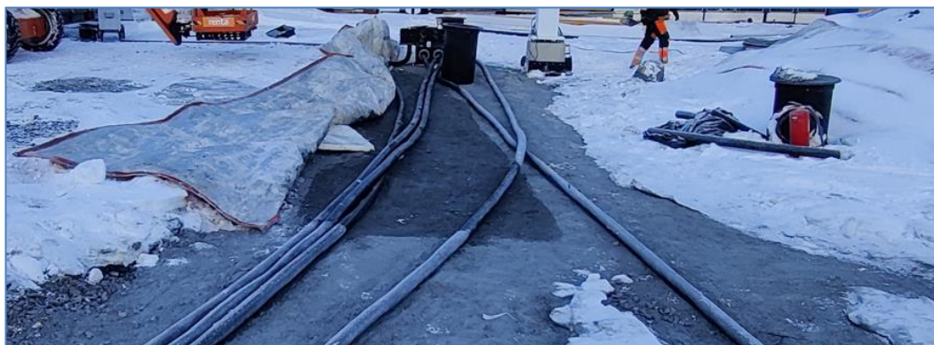
Kuva 7. Polttonesteputkien asennus käynnissä, kuvasta ilmenee selvästi sulatettu alue.
