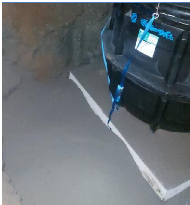
Kuva 14. Polttoaineenerottimen alle asennettu ankkurointilaatta.
