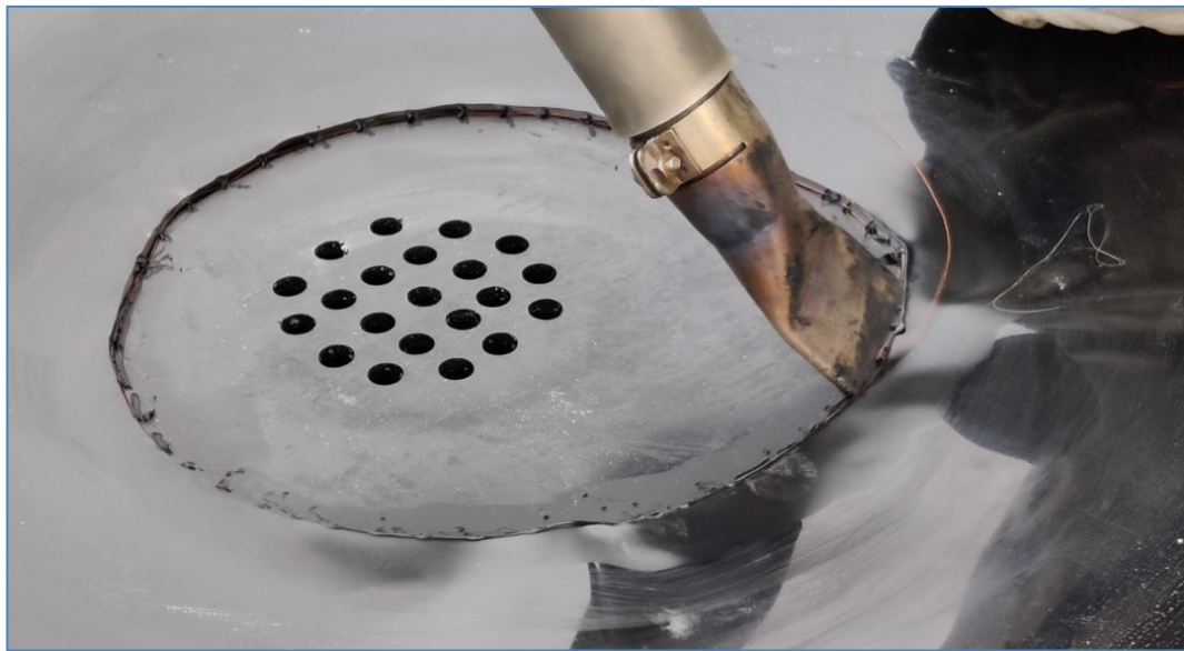
Kuva 18. Kuparilangan kiinnittäminen kalvon ja viemärointi laipan väliin.
