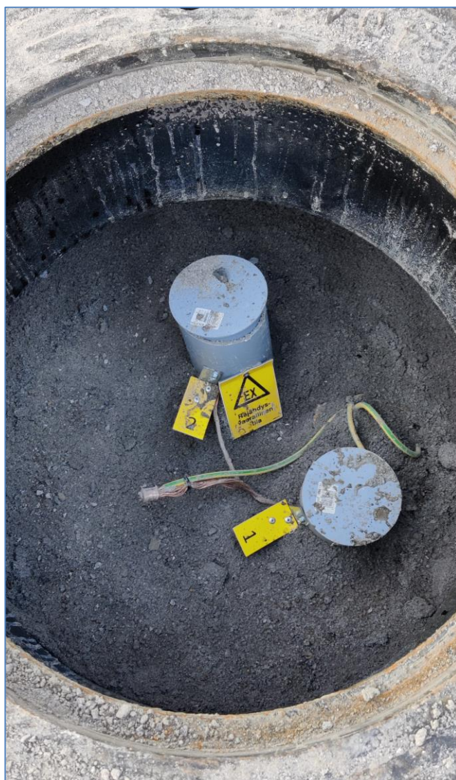
Kuva 10. Huokosilmakaivon merkinnät ja hiekkatäyttö.
