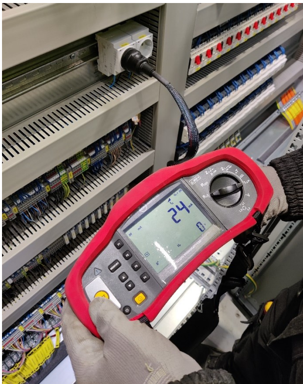
Kuva 9. Vikavirtasuojakytkimen toimintavirran mittaaminen. (Lehtovirta 2022.)
