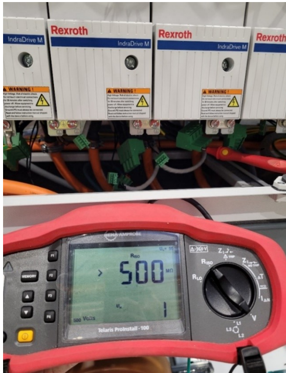
Kuva 7. Moottorikaapeleiden eristysresistanssin mittaaminen. (Lehtovirta 2022.)
