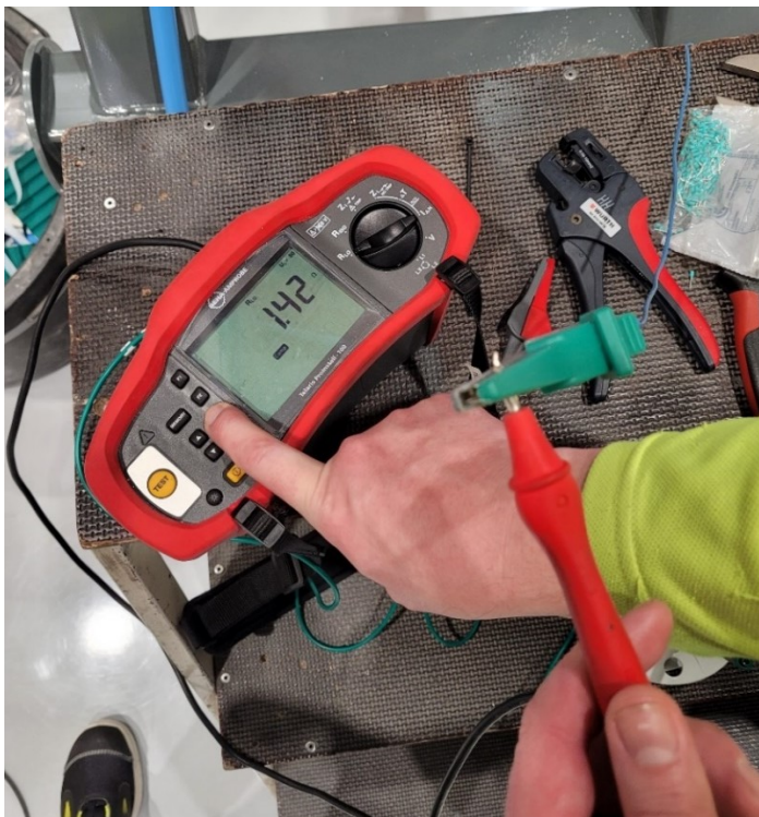
Kuva 5. Mittajohtimien resistanssin nollaaminen. (Lehtovirta 2022.)
