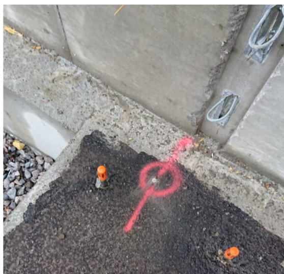
Kuva 6. Betonielementin seinälinjan merkintä naula-ankkuria käyttämällä
