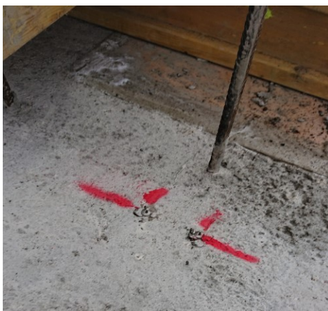
Kuva 16. Elementtien kulmat merkittynä holvin pintaan
