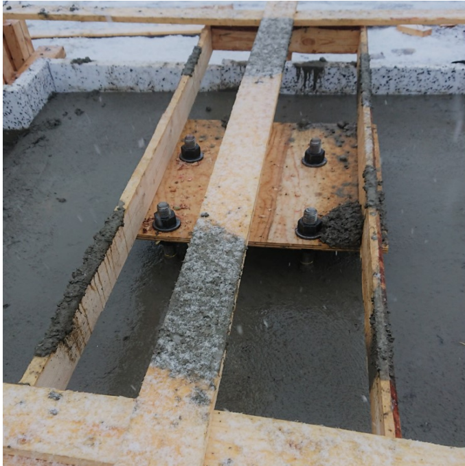
Kuva 14. Pulttimuotti vasta valetussa anturassa
