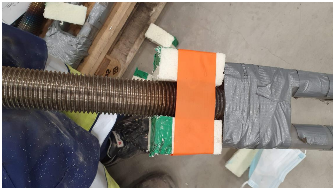
Kuva 17. Valun ajaksi harjaterästen yläpuolelle kiinnitetyt eristepalat.
