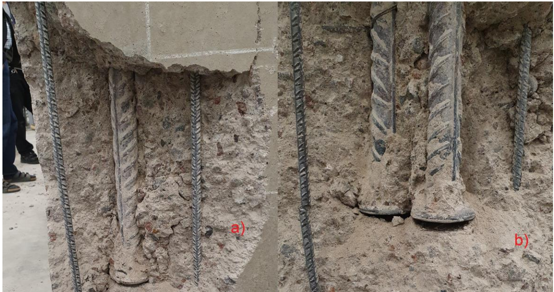
Kuva 31. Tyssän päälle muodostunut kartio murtunutta betonia. a) E34P1, b) E36P1.
