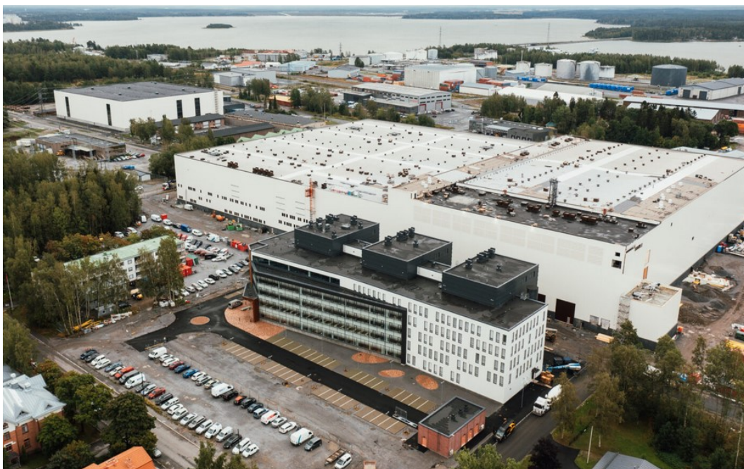
Kuva 1. Wärtsilän Smart Technology Hub ja logistiikkakeskus.
